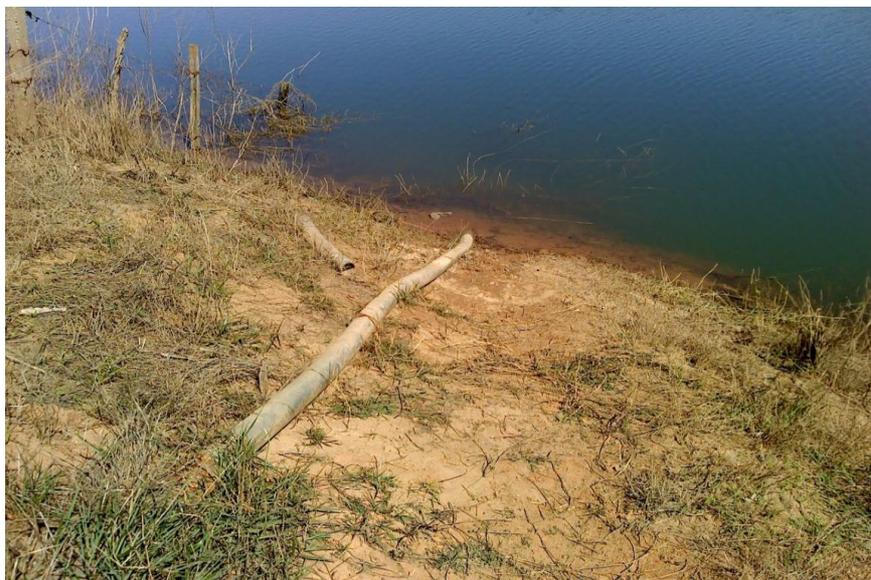
**Foto 02 – Adutora em Mangote Flexível de 100mm de diâmetro.**
