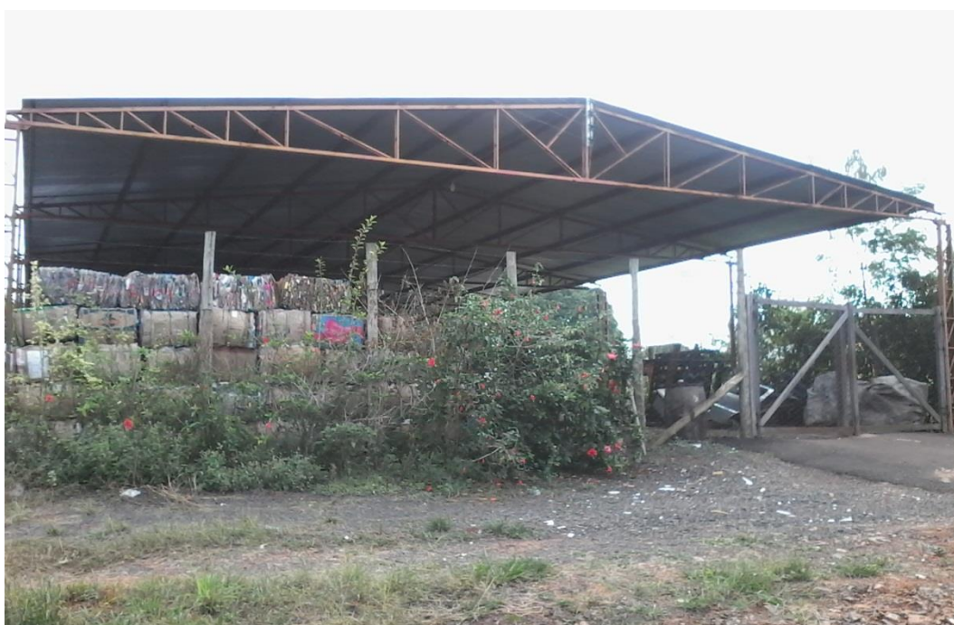
Imagem 40 - Galpão usado para separação e venda de materiais recicláveis
