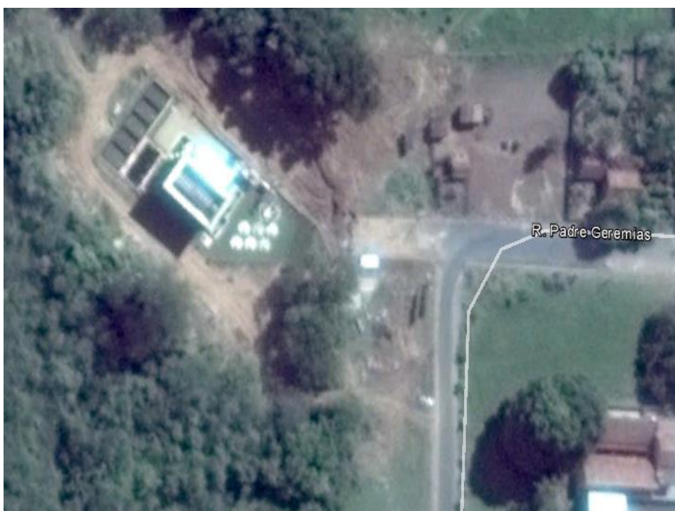
Imagem 21 – Vista aérea da nova estação de tratamento de esgoto (sistema UASB)
