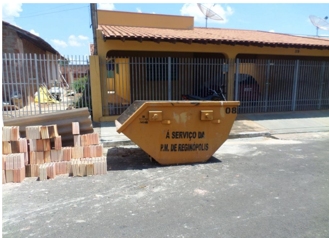
Imagem 45 – Caçamba para acondicionamento dos Resíduos de Construção Civil
