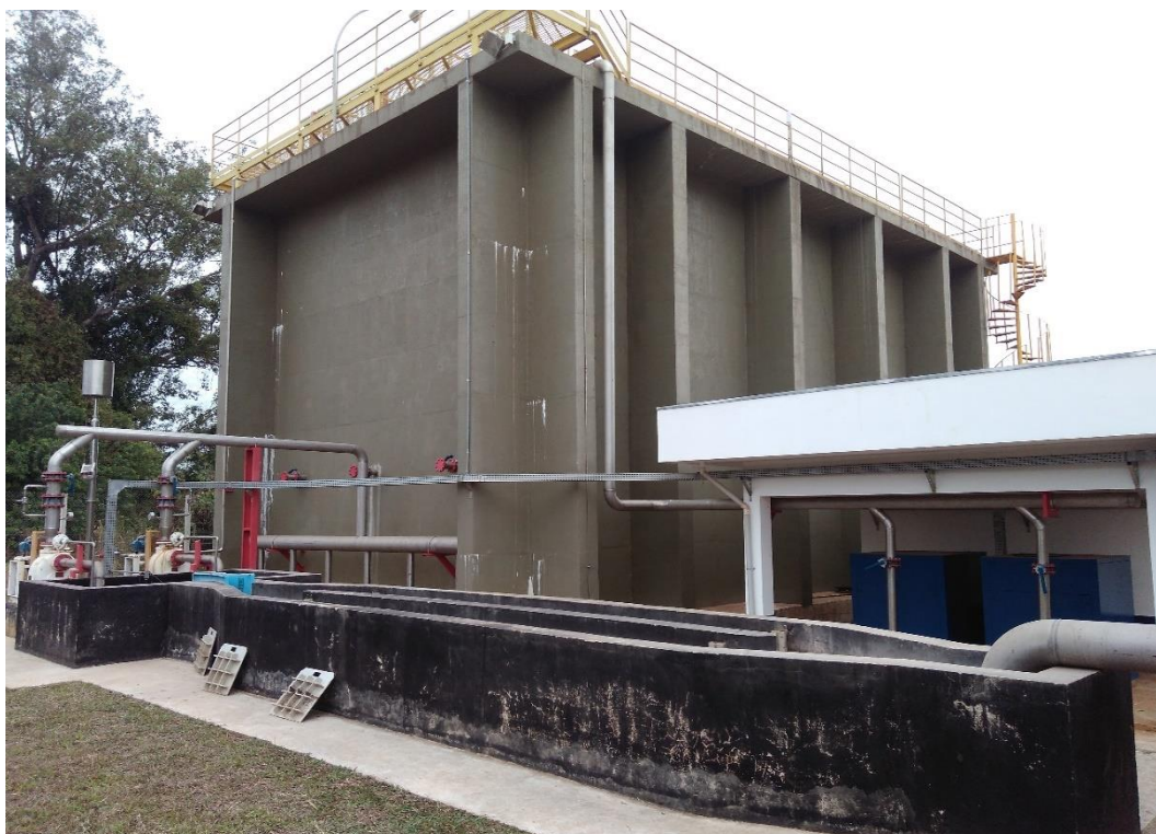
Imagem 24 – Sistema preliminar da nova estação de tratamento de esgoto
