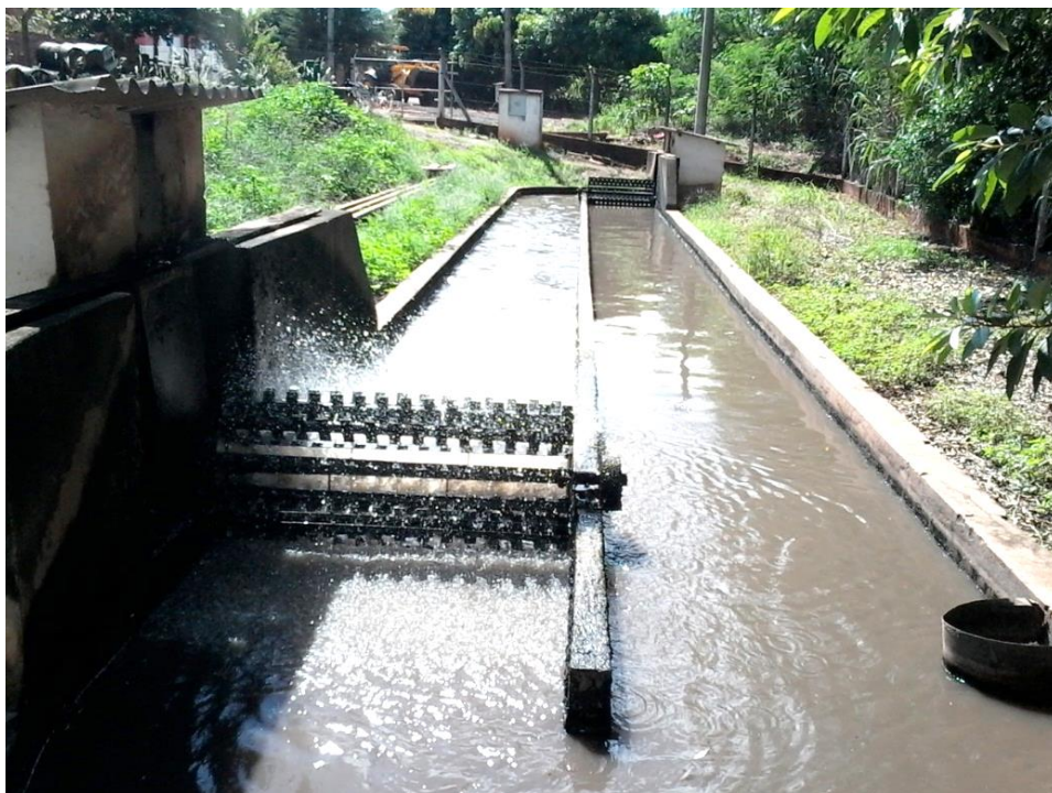
Imagem 20 – Tanque da Estação de Tratamento de Esgoto do Bairro Primavera
