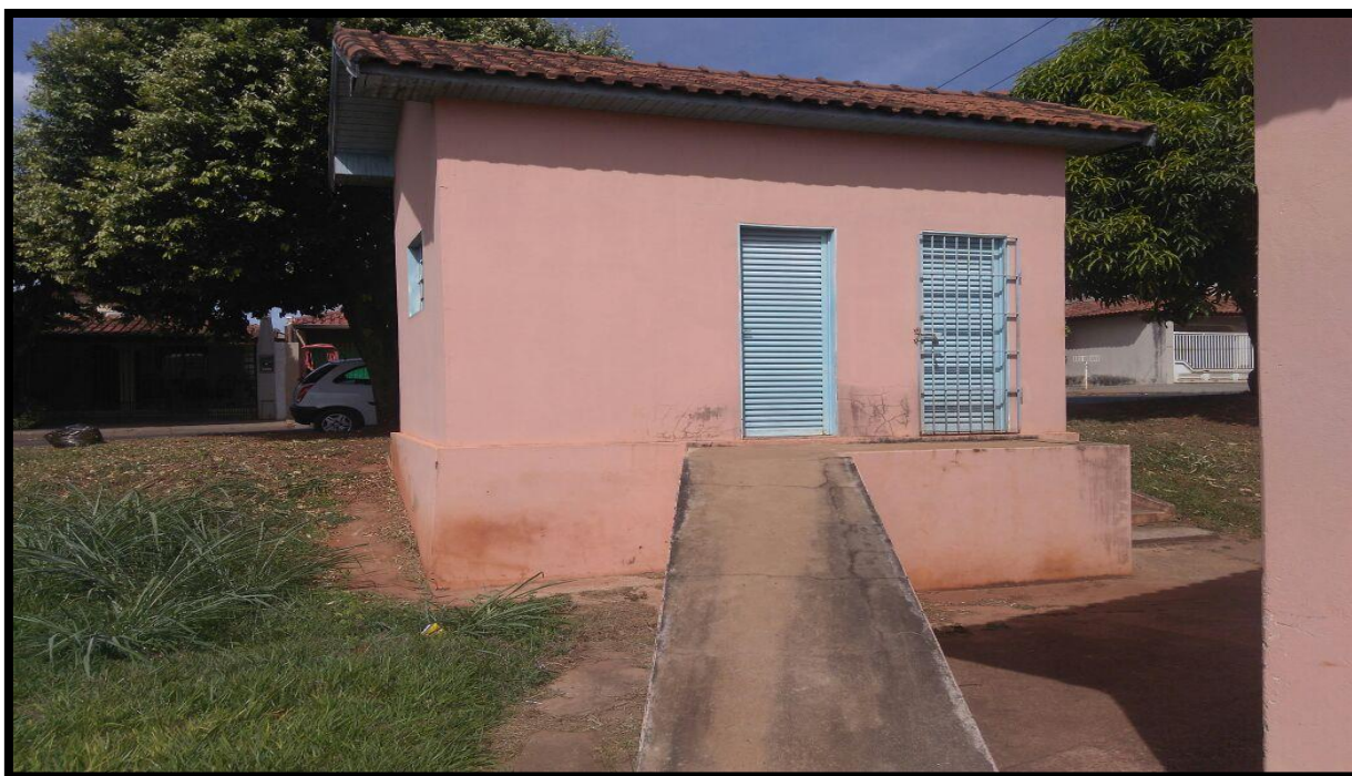
Figura 23. Sala onde são depositados os Resíduos de Serviço de Saúde a serem descartados.
