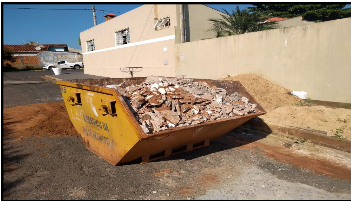
Figura 20. RCC acondicionados em caçamba.
