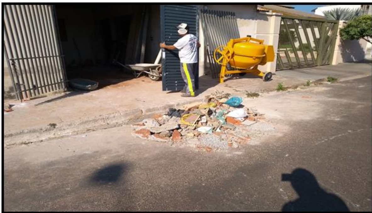
Figura 21. RCC depositado diretamente na calçada.
