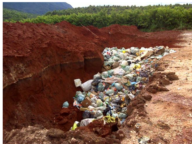
FOTOS 4.19 E 4.20 - ATERRO SANITÁRIO DE RIBEIRÃO BRANCO – VALAS PARA DISPOSIÇÃO DE LIXO
