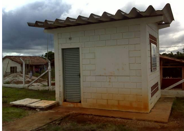
FOTO 4.9 – VISTA DA EEAT DA ITABOA
