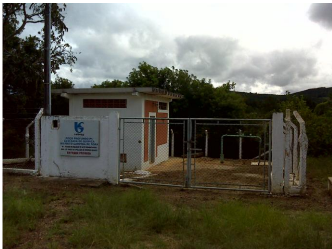
FOTO 4.12 – VISTA DO POÇO PROFUNDO DE CAMPINA DE FORA
