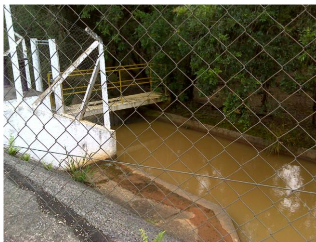
FOTO 4.1 – VISTA DA CAPTAÇÃO - RIBEIRÃO DOS PIRES
