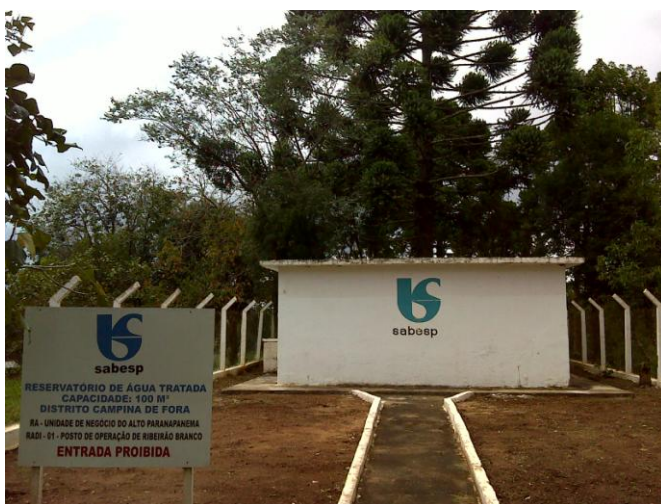
FOTO 4.13 - VISTA DO RESERVATÓRIO DE CAMPINA DE FORA
