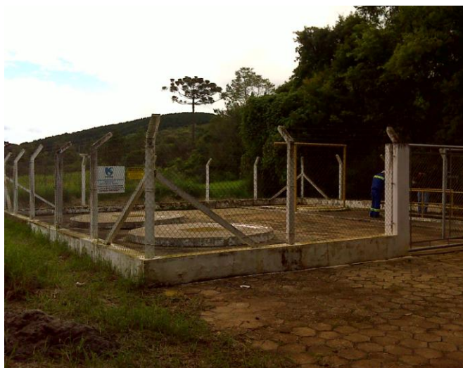
FOTO 4.16 - VISTA DA EEE IPIRANGA - BAIRRO ITABOA
