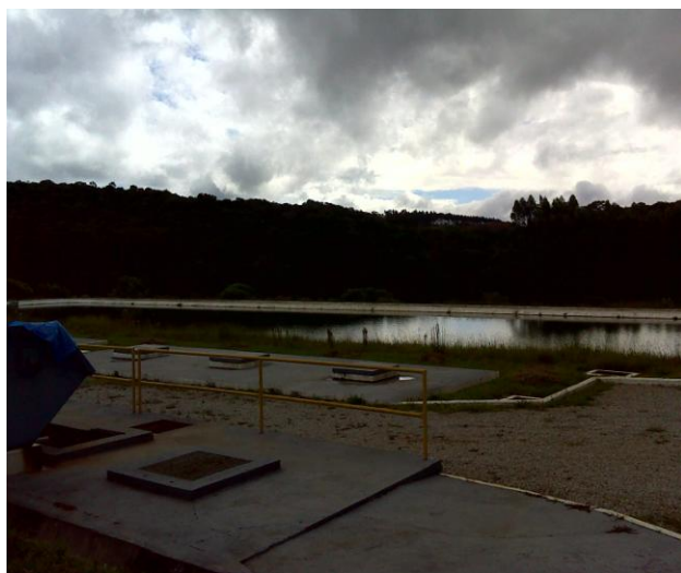
FOTO 4.18 - VISTA DA ETE ITABOA
