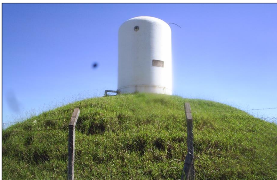
Foto 6 - Reservatório apoiado 03 (RA03)
