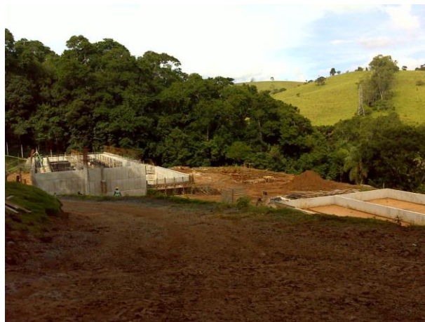
FOTO 4.22 – FUTURA ETE (EM CONSTRUÇÃO)
