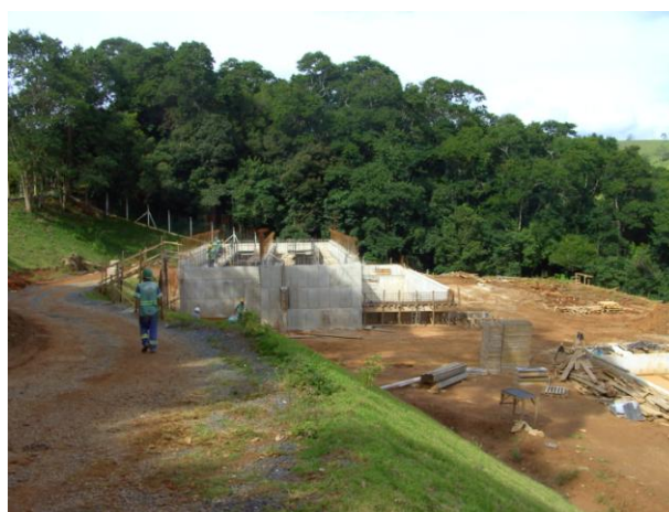
FOTO 4.20 – FUTURA ETE (EM CONSTRUÇÃO)
