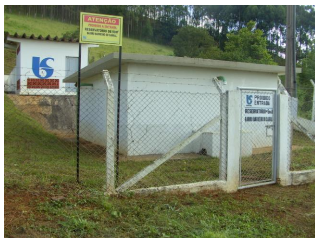
FOTO 4.11 – RESERVATÓRIO APOIADO R6
