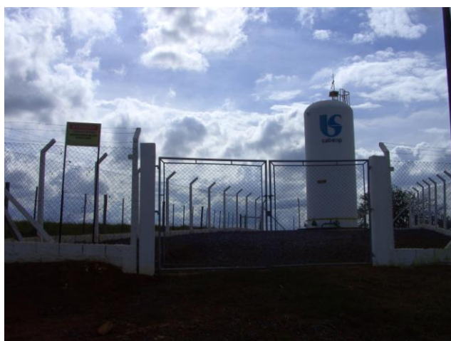
FOTO 4.8 – RESERVATÓRIO APOIADO R3
