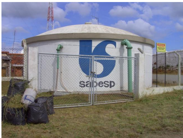
FOTO 4.6 – RESERVATÓRIO APOIADO R1
