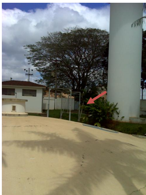
FOTO 4.2 – EEAT CAPÃO BONITO/RIB. GRANDE (SETA)
