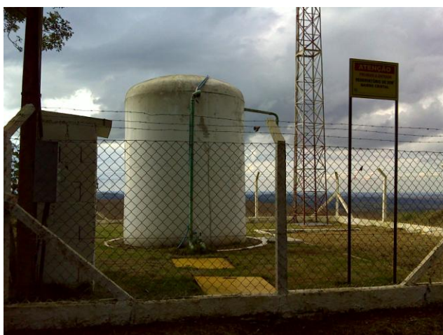
FOTO 4.10 – RESERVATÓRIO APOIADO R5
