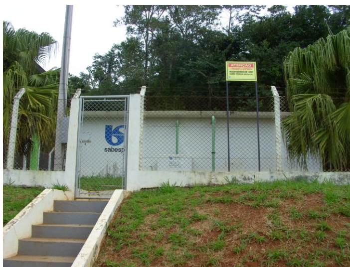
FOTO 4.12 – RESERVATÓRIO DO BAIRRO FERREIRA DOS MATOS
