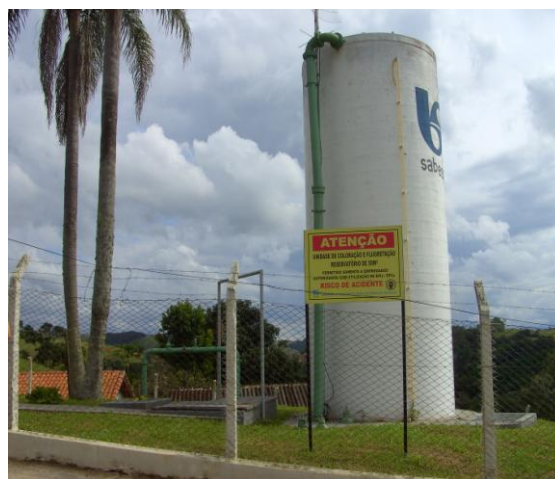
FOTO 4.7 – RESERVATÓRIO APOIADO R2
