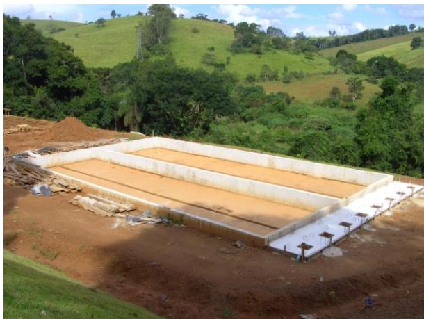
FOTO 4.21 - FUTURA ETE (EM CONSTRUÇÃO)
