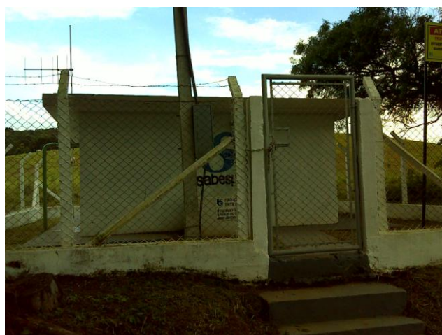
FOTO 4.9 – RESERVATÓRIO APOIADO R4
