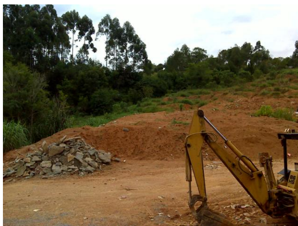
FOTO 4.27 – ÁREA DE DEPOSIÇÃO DOS RESÍDUOS INERTES
