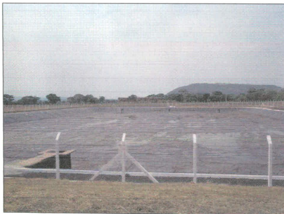
Foto 15 - Lagoa Facultativa em fase final de construção
