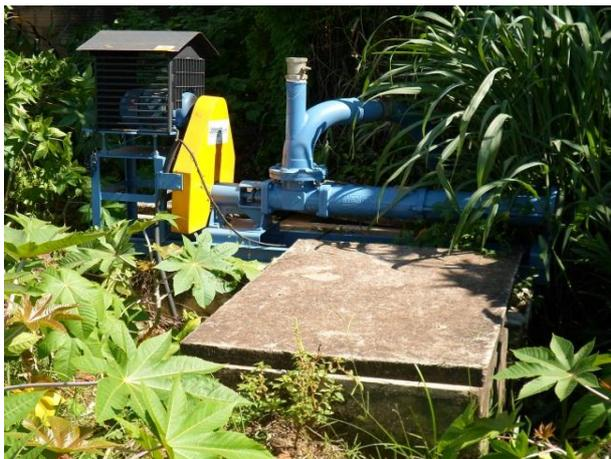
Foto 4.10 - Estação Elevatória de Esgoto
