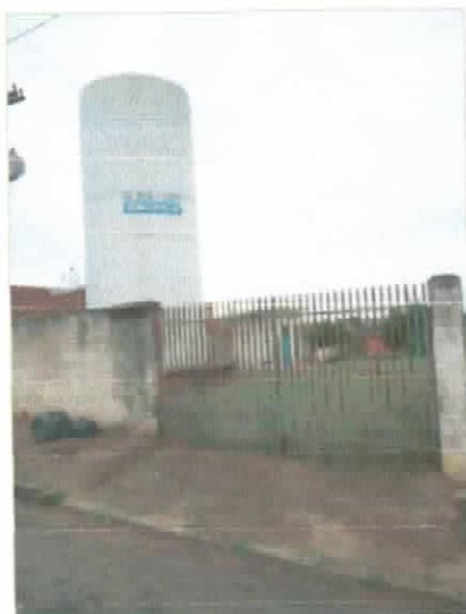
Foto 18 – Reservatório elevado de 80 m 3
