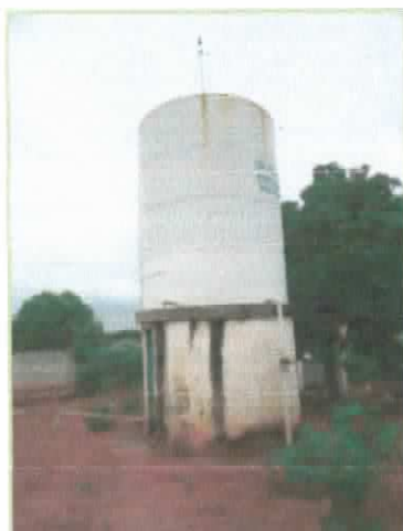
Foto 16 - Reservatório elevado de 30 m 3
