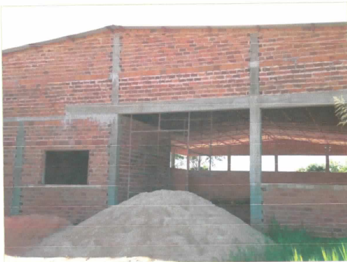
Foto 6 – Futuras instalações do barracão de triagem
