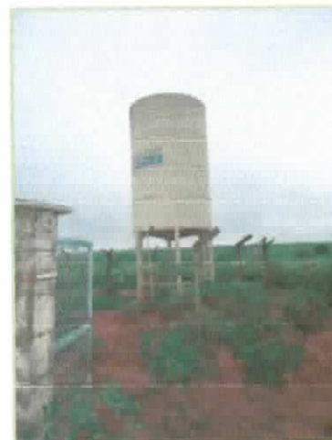
Foto 17 – Reservatório elevado de 40 m 3
