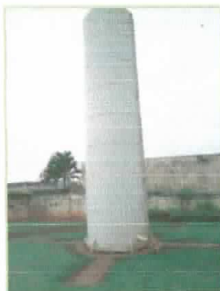
Foto 14 – Reservatório elevado, de 50 m 3
