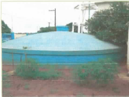
Foto 12 – Reservatório enterrado de 350 m 3
