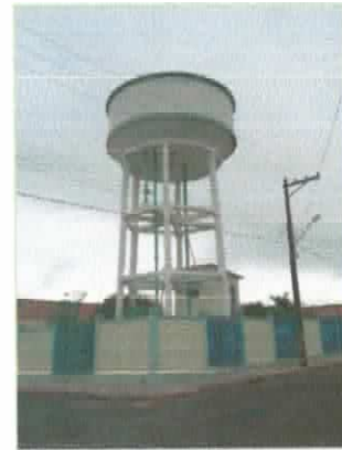
Foto 13 – Reservatório elevado de 150 m 3
