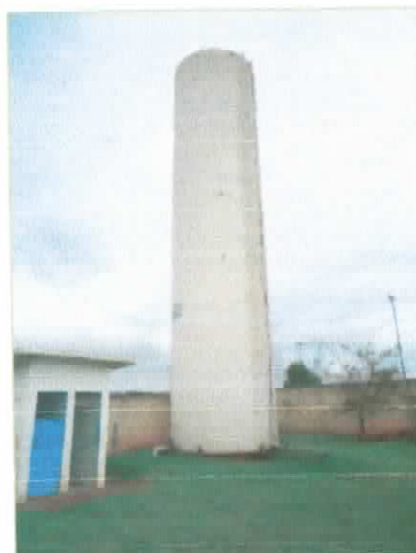
Foto 19 – Reservatório elevado de 80 m 3
