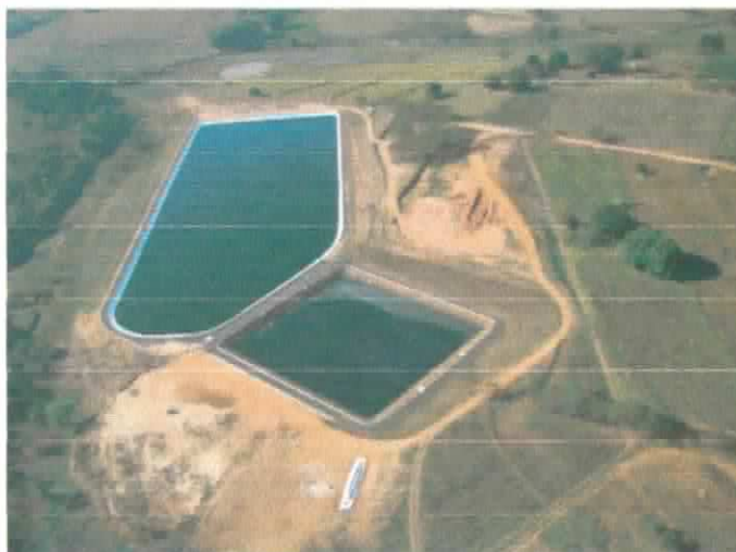
Foto 20 – Estação de Tratamento de Esgoto
