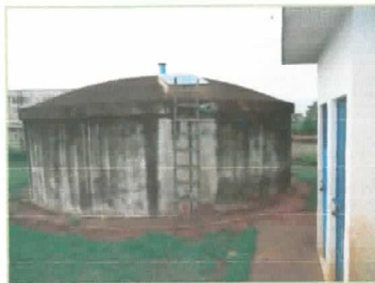
Foto 15 – Reservatório semi-enterrado, de 150 m 3
