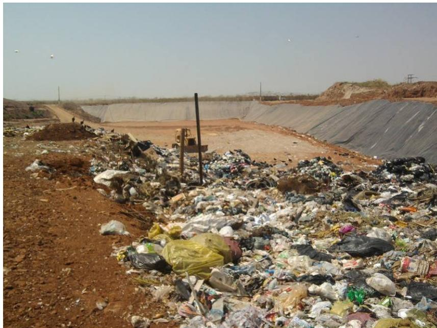
Figura 11.1.1.67. Detalhe do revestimento da manta de PEAD nas laterais das valas
