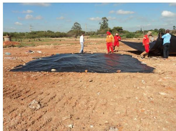
Figura 11.1.1.7. Detalhe da lona em área do aterro próxima à frente de operação
