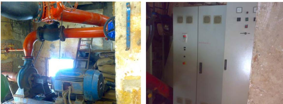
Figura 15 - à esq., CMB da represa Bom Jesus I; à dir., inversor de frequência
