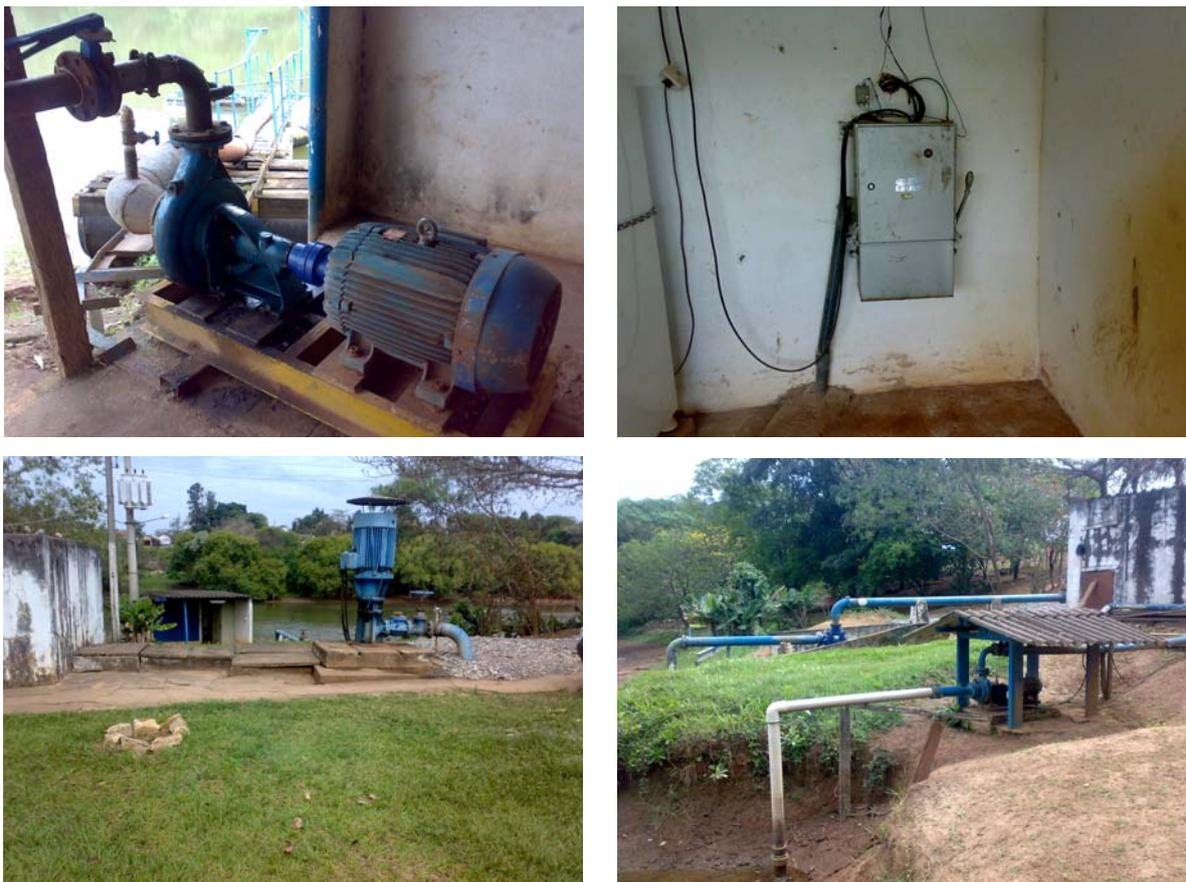
**Figura 13 - No sentido horário, a partir do canto superior esq.: CMB da represa São Jorge II, Painel do CMB, CMB auxiliar da bomba de eixo vertical, caixa e CMB de eixo vertical**
