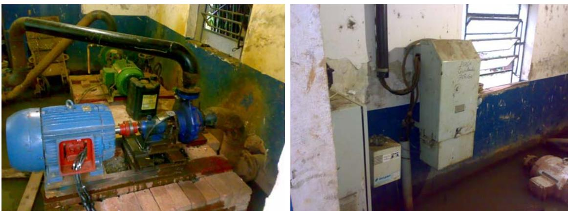
Figura 19 - à esq., os dois CMBs da represa Dona Rosina e à dir. o quadro de acionamento dos motores
