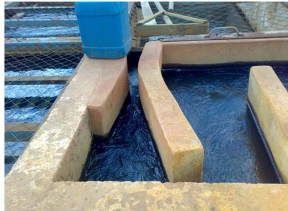
Figura 22 - à esq., chegada de água bruta na ETA I; à dir., calha Parshall da ETA II
