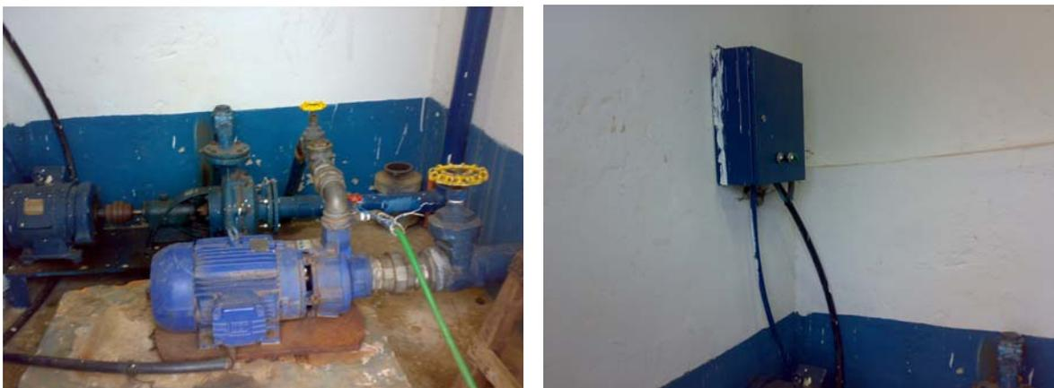
Figura 28 - à esq., os dois CMBs São Cristóvão II; à dir. o quadro de acionamento dos motores
