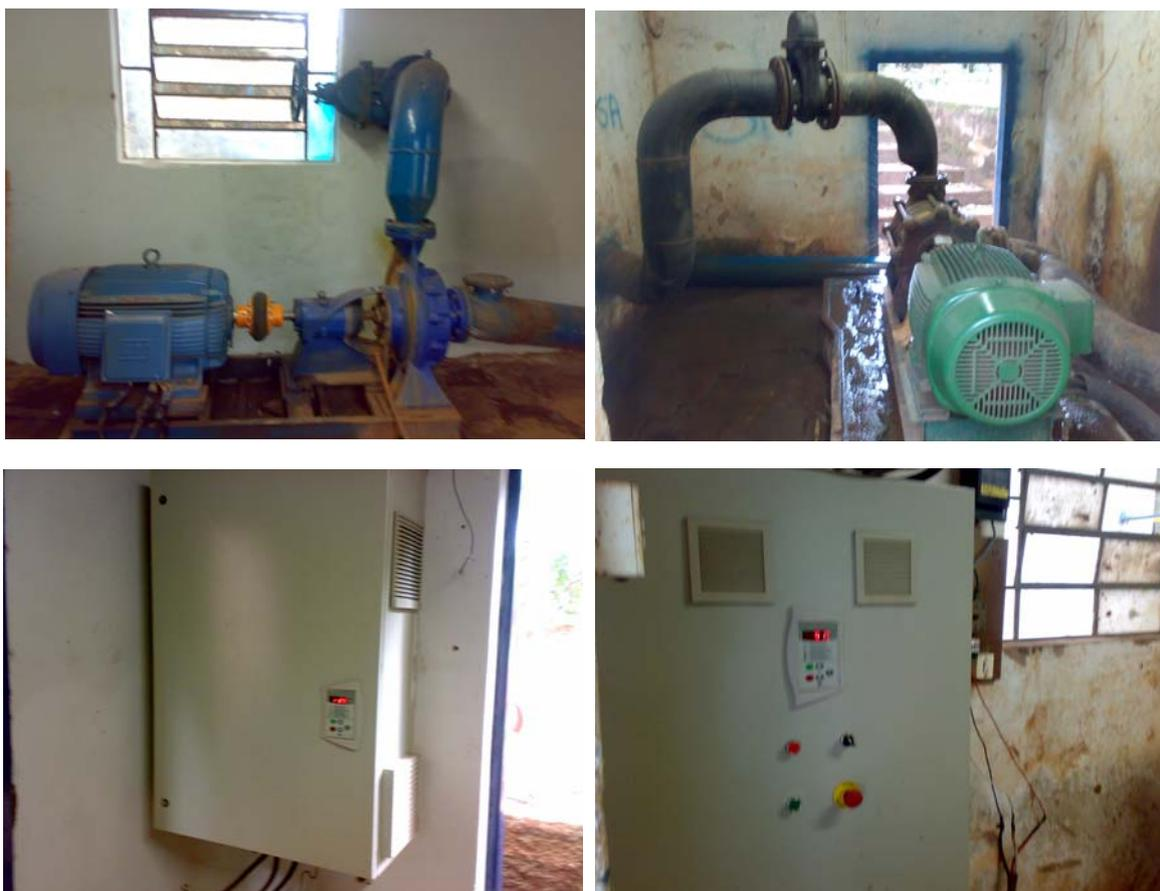
Figura 17 - a partir do canto sup. esq., no sentido horário: CMB de menor capacidade, CMB de maior capacidade, inversor de frequência do CMB menor e inversor de frequência do CMB maior
