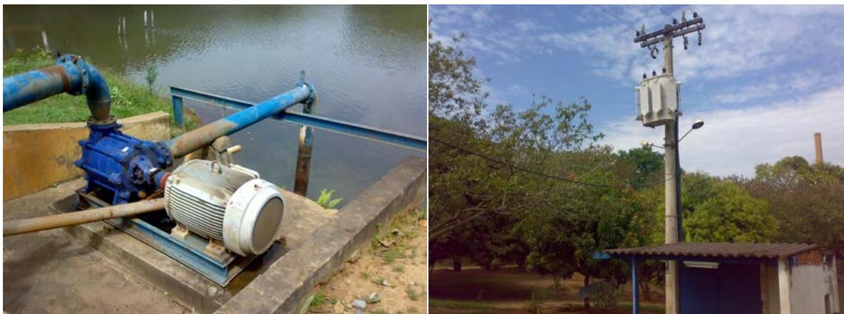
Figura 12- à esq., CMB a céu aberto e à dir., transformador da unidade - 150 kva
