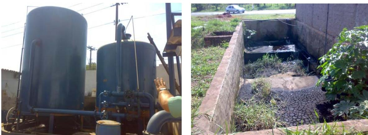
**Figura 25 - à esq., ETA III metálica compacta e à dir., sistema de recuperação de água de lavagem**
