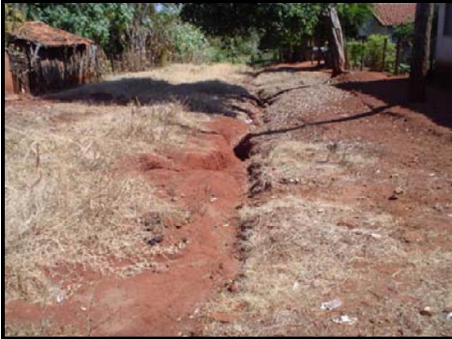
Figura 67 - Erosão Laminar em rua sem pavimentação
