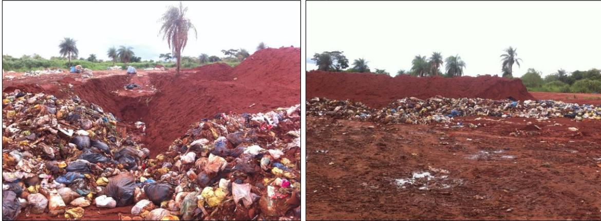
Para a operação do aterro utiliza-se de uma pá carregadeira, que executa a abertura das valas, e auxilia também no recobrimento dos resíduos com material de cobertura. Neste caso, o material utilizado é o próprio material advindo da abertura das valas, que fica armazenado no local.
