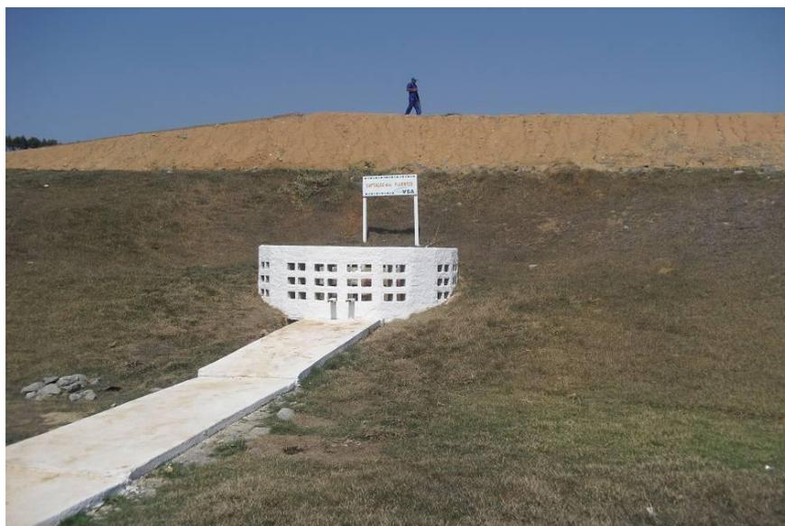
Foto 05 – Poço de Captação de Líquidos Percolados.
