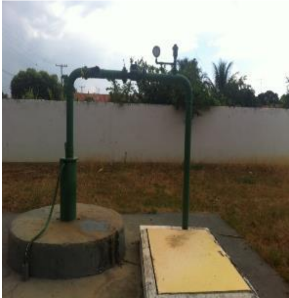
Figura 34. Poço PPS2 – Bairro Rural de Caramuru
