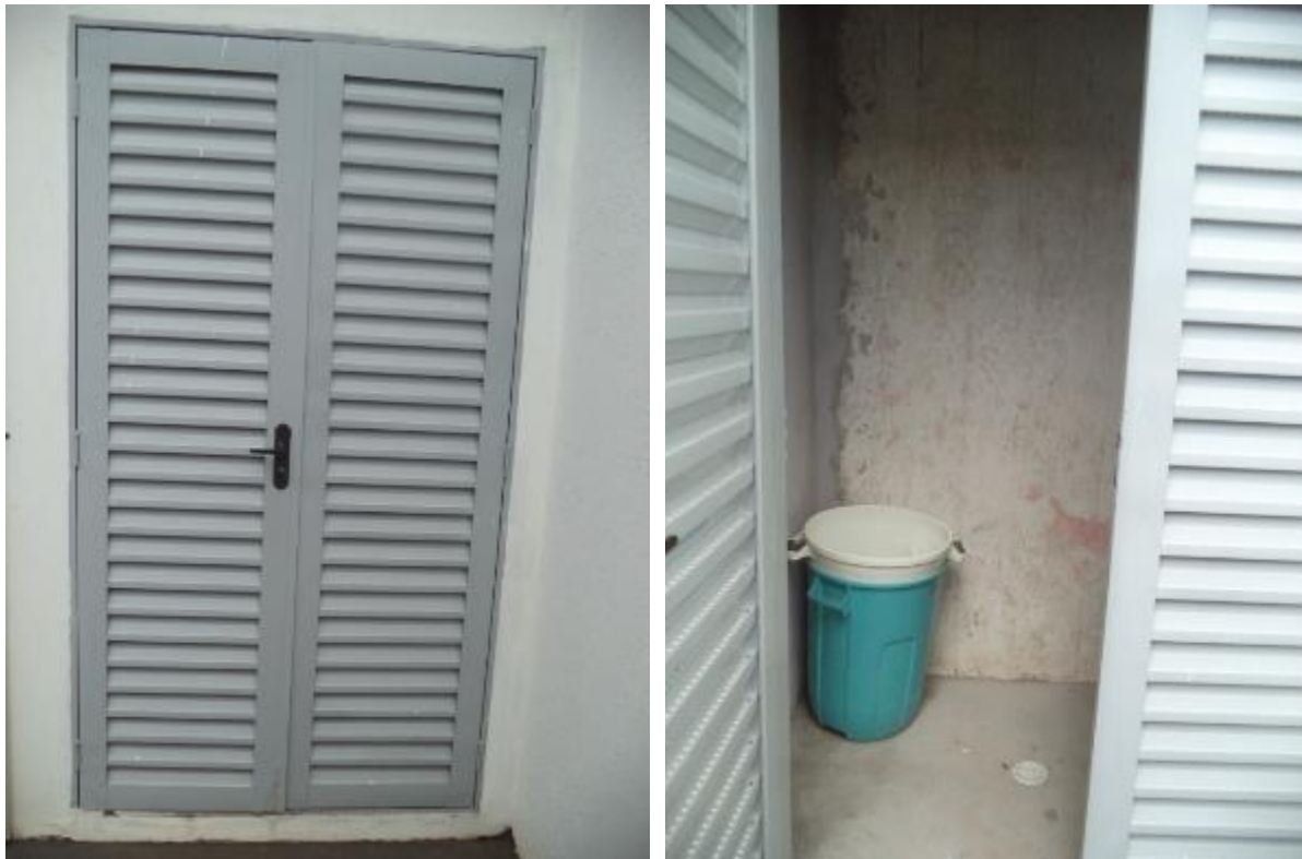
Figura 119. Local de acondicionamento dos RSS do Município
