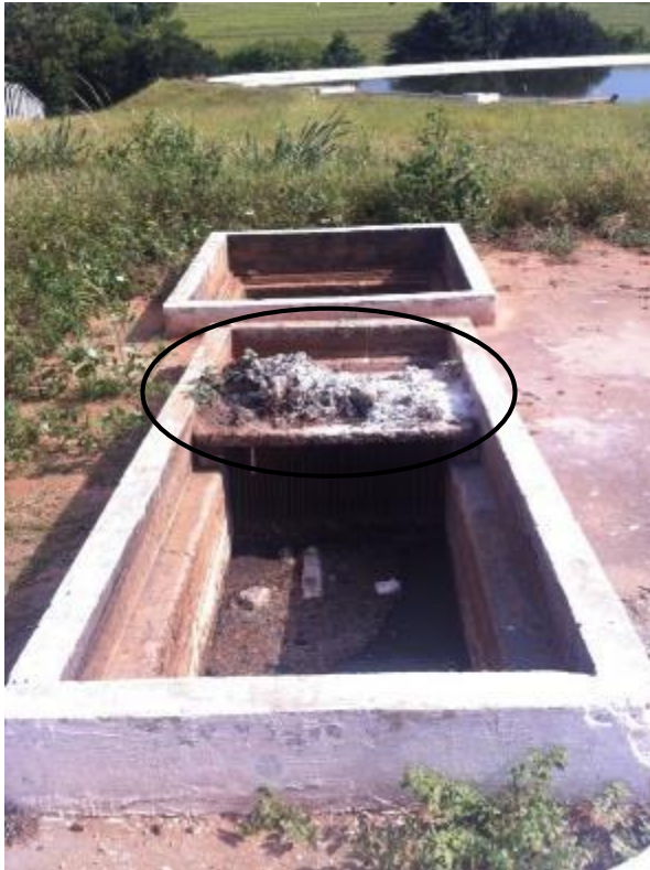
Figura 145. Resíduos provenientes da limpeza do gradeamento
