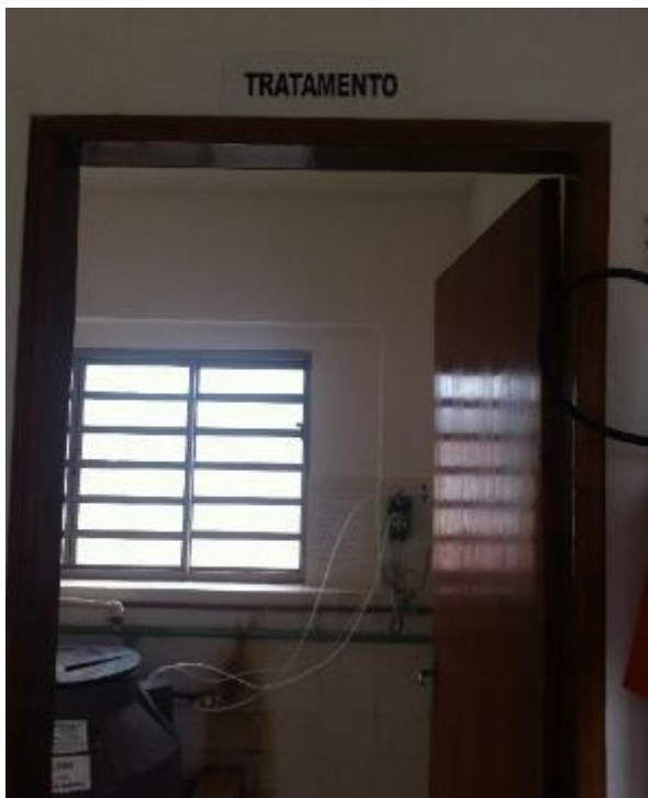
Figura 35. Casa de química para água de abastecimento – Bairro Rural de Caramuru
