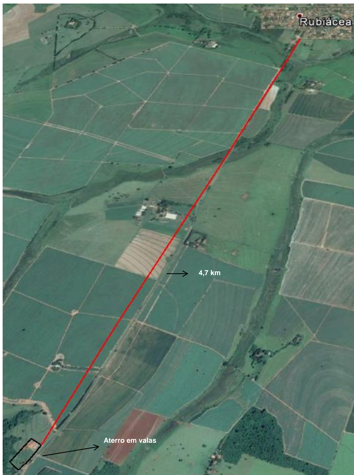
Figura 89. Imagem de satélite contemplando a distância do aterro em valas de Rubiácea até malha urbana
