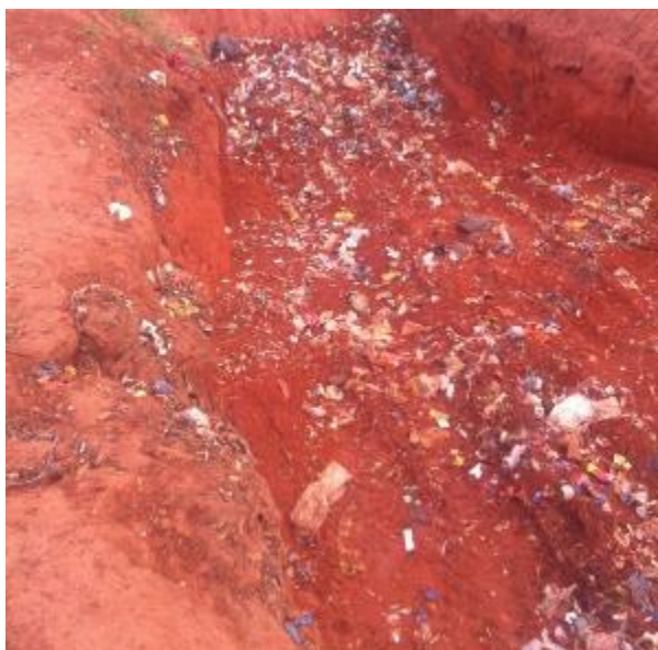
Figura 92. Ausência da cobertura total dos resíduos
