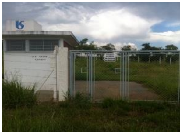
Figura 46. Tratamento Preliminar com Reator Anaeróbio – ETE2
