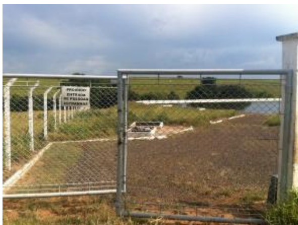
Figura 45. Estação de Tratamento de Esgoto – ETE1
