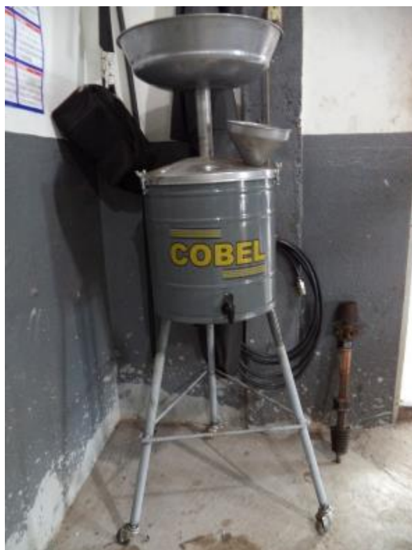
Figura 136. Oficina Mecânica Pelegrini e os recipientes de armazenamento de óleo queimado
