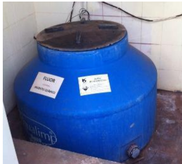
Figura 33. Cloração e fluoretação da água para abastecimento
