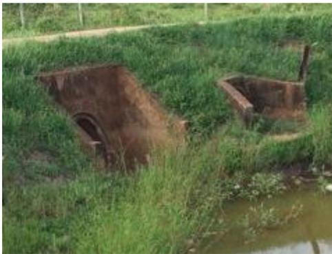
Figura 26 - Saída das águas pluviais da lagoa de retenção
