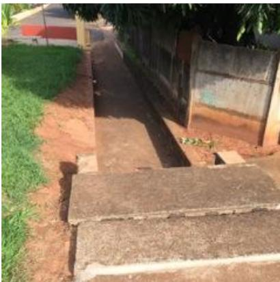
Figura 29 - Canaleta de passagem das água pluviais para a lagoa
