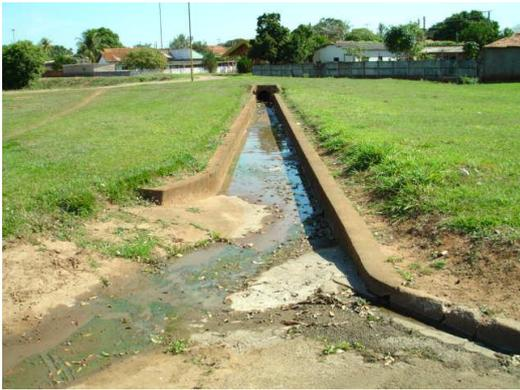
Figura 31 - Canaleta de captação de águas pluviais
