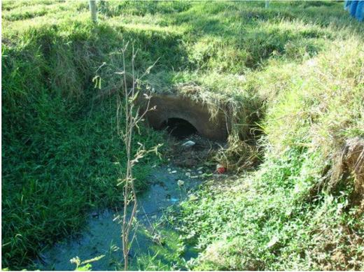
Figura 35 - Tubulação de saída das águas pluviais
