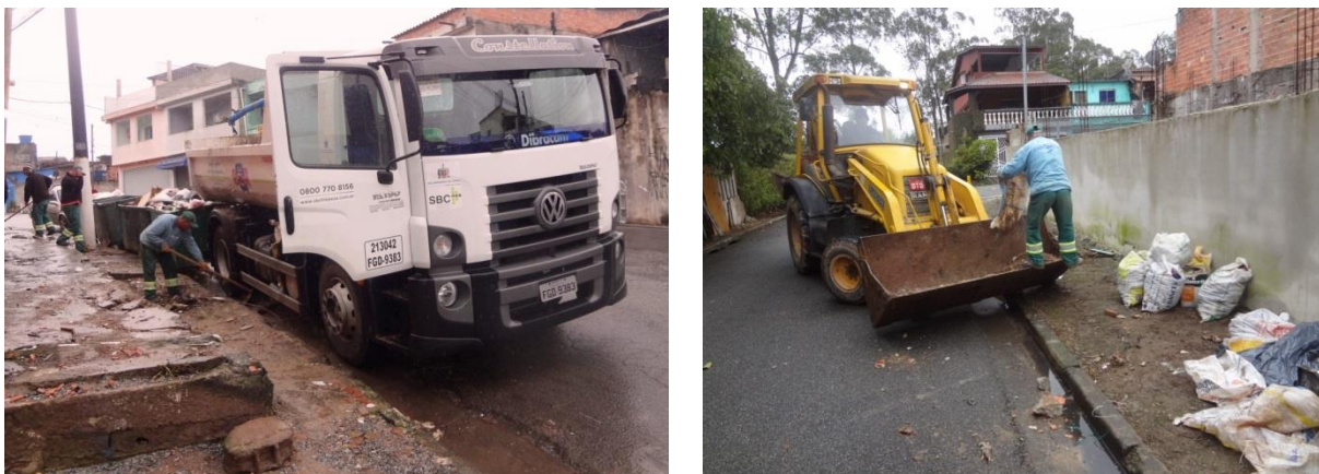
Figura 20 Equipe de limpeza de pontos viciados e equipamentos utilizados no serviço
