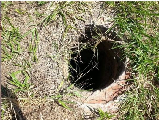
**Figura 49** Poço de visita do sistema de drenagem aberto.
