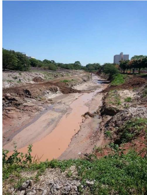
**Figura 26** Bacia de retenção para amortecimento da água da chuva – Bacia do córrego Borá.
