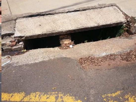
**Figura 47** Vazamento de esgoto para o sistema de drenagem.
