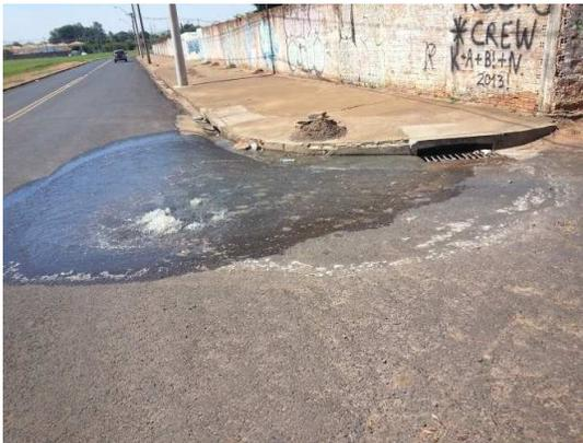
**Figura 48** Poço de visita do sistema de drenagem aberto.
