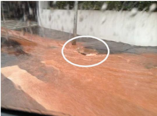
**Figura 69** Consequências da falta de estruturas adequadas de microdrenagem.
