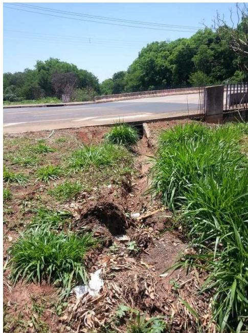
**Figura 45** Boca de lobo com necessidade de reparo – lançamento no córrego Borá.
