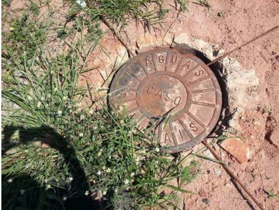
**Figura 50** Poço de visita do sistema de drenagem aberto.
