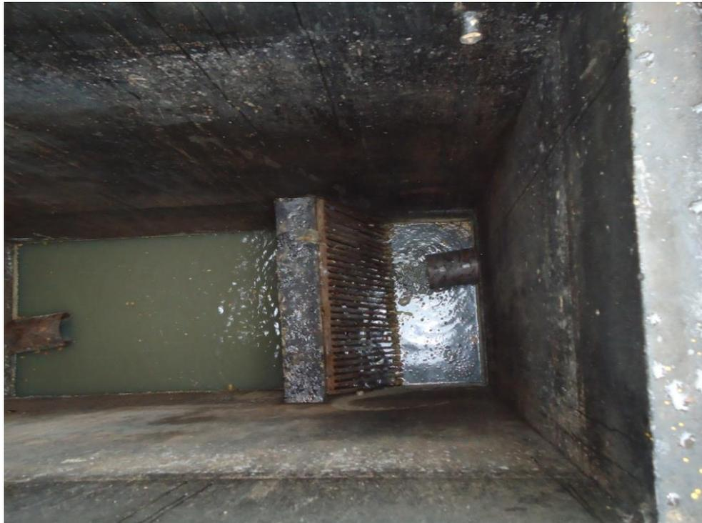
Foto 8 - Sistema de gradeamento da E.E.E. 01
