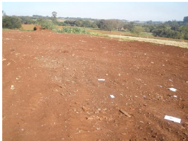
VALA DO ATERRO FINALIZADA
