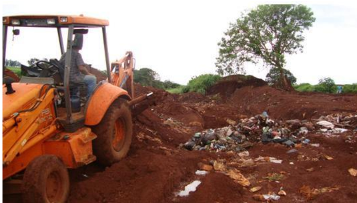
ATERRO SANITÁRIO ANTES DA COBERTURA DO LIXO DEPOSITADO NO DIA
