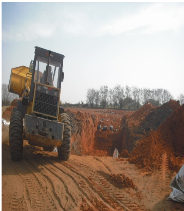
Figura 5 – Aterro Licenciado em Vala – SALES/SP
