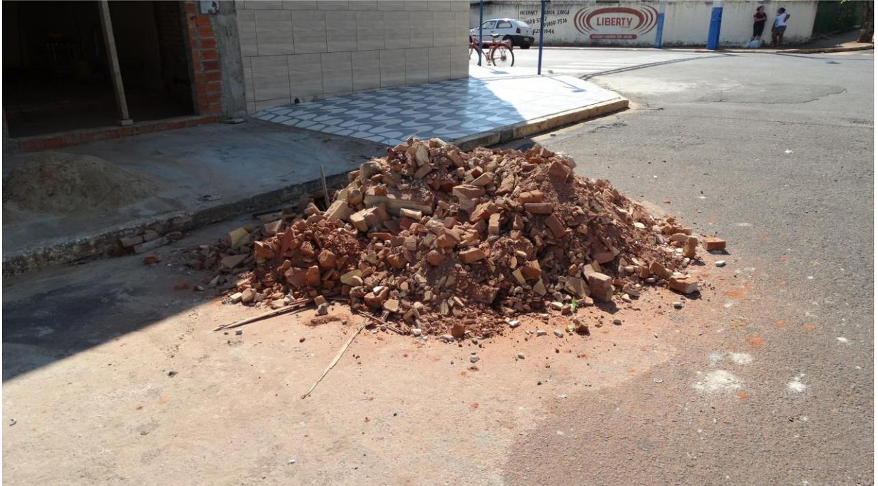
Imagem 42: *resíduos de construção dispostos no meio fio, dispostos para o serviço de coleta.*
