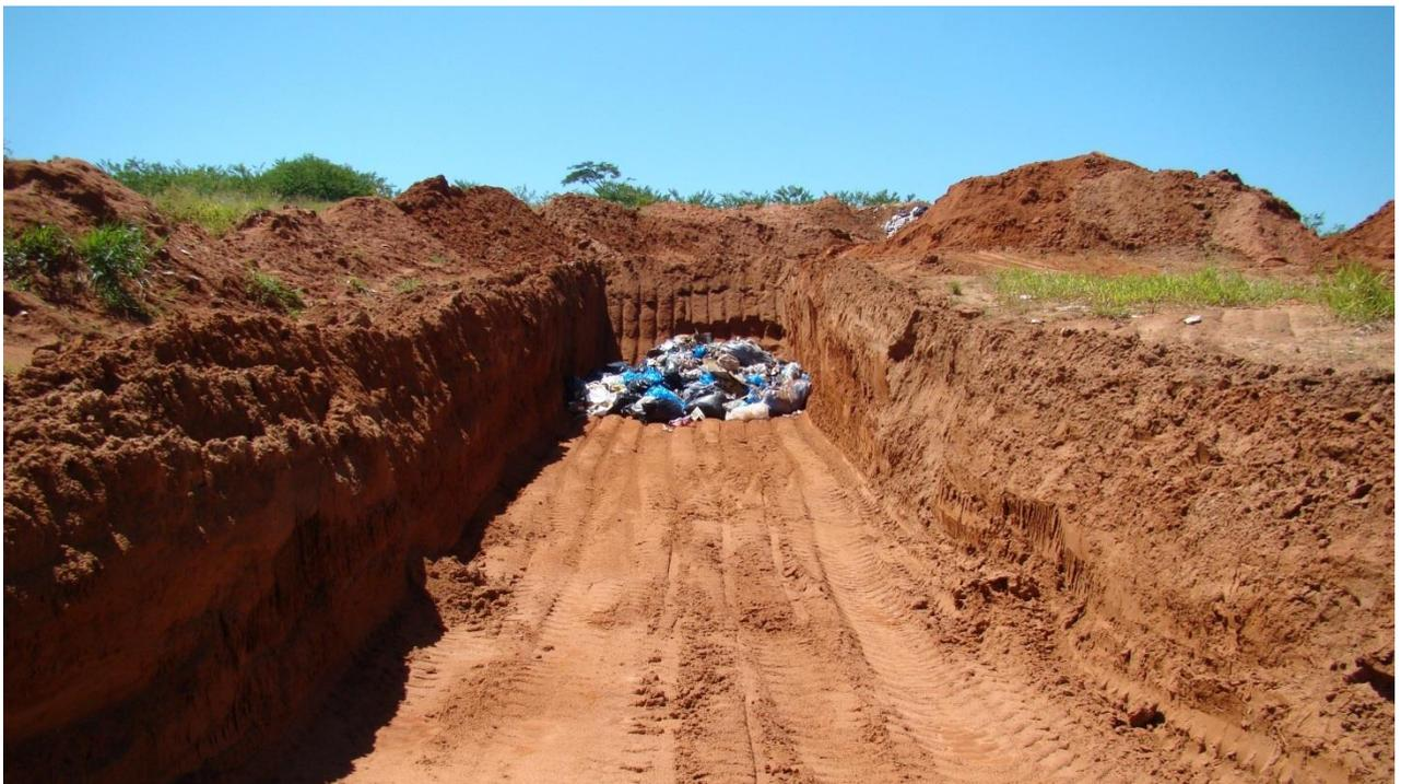
Imagem 25: *vista interna do aterro em valas, com destaque para abertura de valas e destinação final dos resíduos.*
