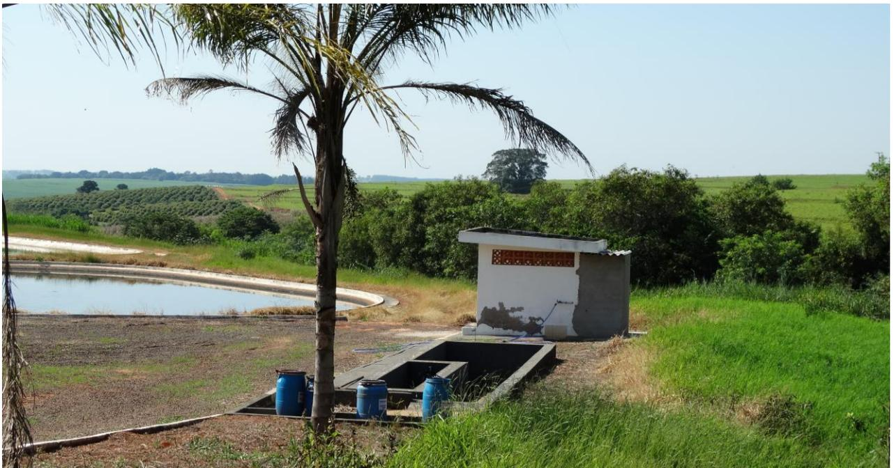
Imagem 49 – lodo originado do esgoto sendo secado e acondicionado em tambores.
