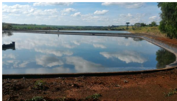
Estação de Tratamento de Esgoto (ETE)
