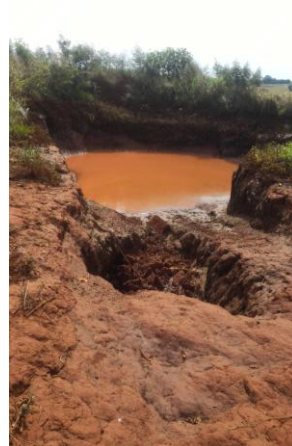
Ponto de erosão – Final da Rua Huet Bacelar
