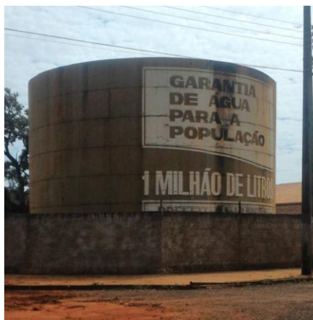
Reservatório de água do Milhão
