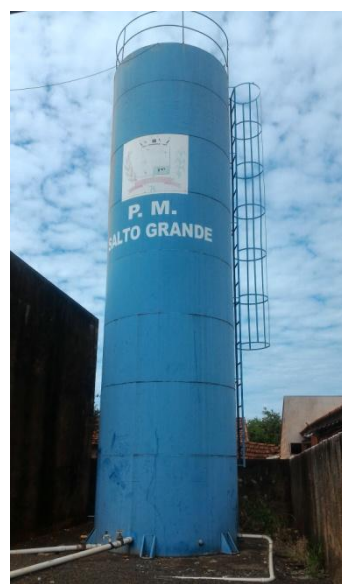
Foto 3.12 – Reservatório Santo Antônio
