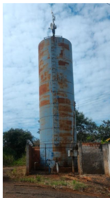
Foto 3.16 – Reservatório do Barreto
