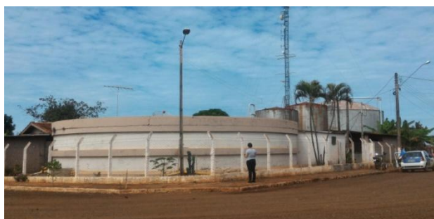
Foto 3.10 – Reservatórios do Cemitério
