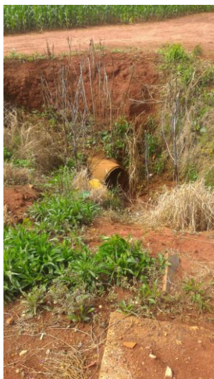
Foto 3.26 – Final da rede de drenagem na erosão
