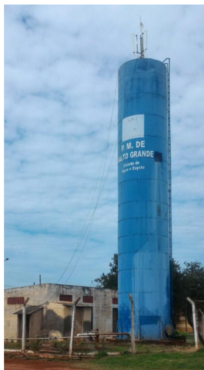
Foto 3.14 – Reservatório do Bocha
