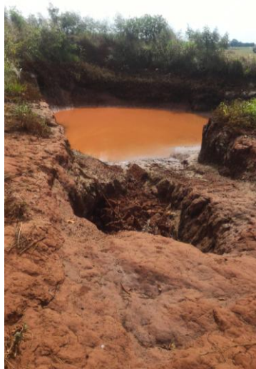
Foto 3.27 – Outra vista da erosão
