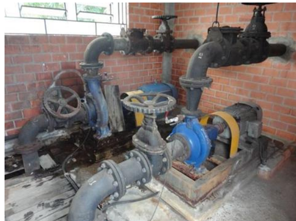
Figura 89. Vista Geral dos conjuntos motor-bomba do Booster Floriano.
