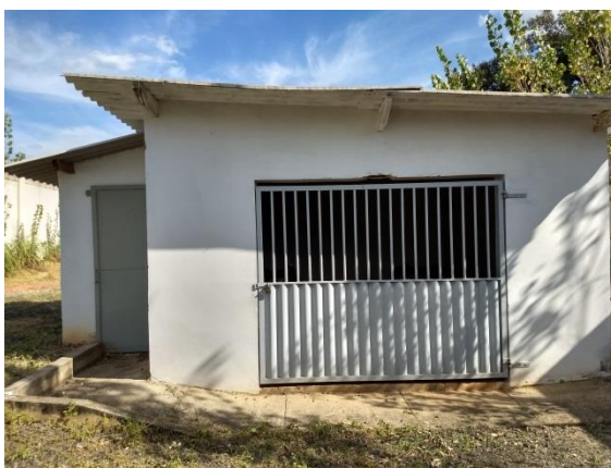
Figura 131. Estação Elevatória de Esgoto – Portal dos Bandeirantes - Vista 1.
