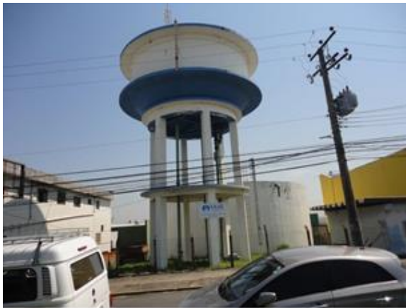
Figura 47. Vista Geral do EAT Jardim Cidade (Siemens).
