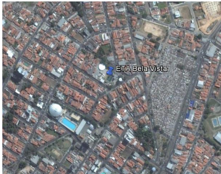
Figura 26. Posição relativa da ETA - Bela Vista no município de Salto.
