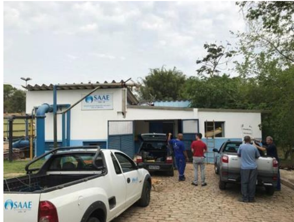
Figura 28. Vista geral da ETA João Jabour.
