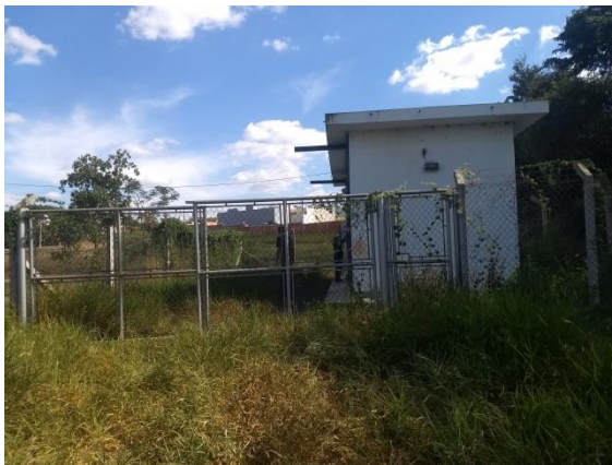
Figura 133. Estação Elevatória de Esgoto – Moutonnée - Vista 1.
