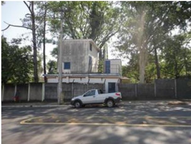
Figura 43. Vista Geral do Booster Estação.
