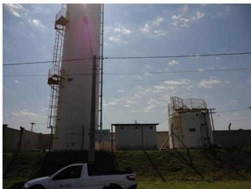
Figura 79. Vista Geral do EAT Portal dos Bandeirantes.
