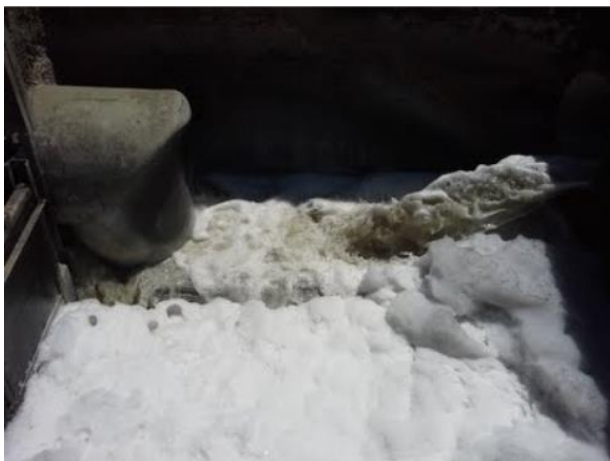
Figura 93. Vista do Efluente Final antes do Lançamento.
