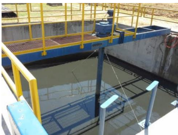
Figura 99. Vista de um dos módulos desarenadores.
