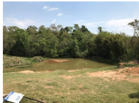
Figura 22. Vista Geral da Captação Conceição.
