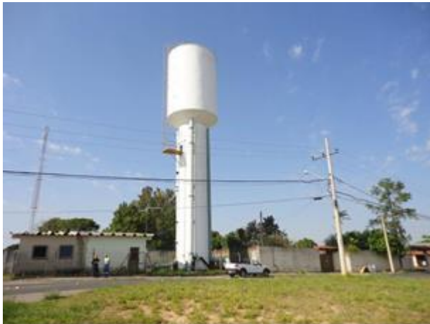
Figura 63. Vista Geral do EAT João Jabour.
