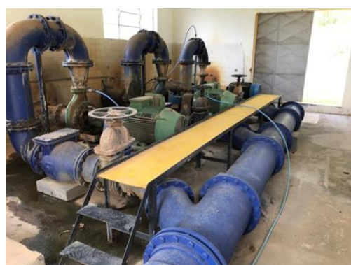
Figura 15. Vista Geral do barrilete de recalque da captação.
