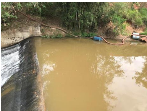
Figura 19. Vista Geral da Captação João Jabour.
