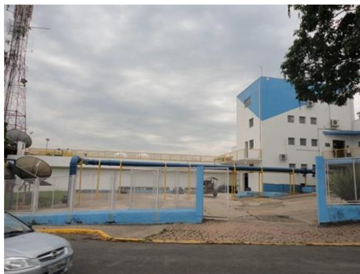
Figura 27. Vista Geral da ETA Bela Vista.
