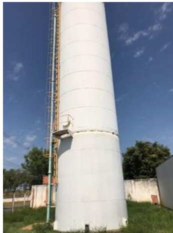
Figura 87. Vista Geral do Reservatório Elevado do EAT Madre Paulina.
