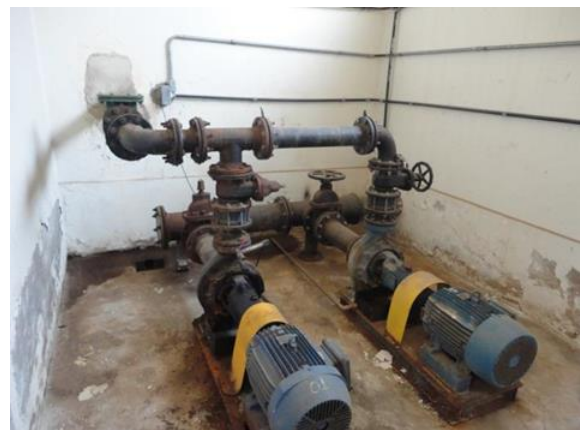
Figura 58. Conjuntos motor - bomba do EAT Jurumirim.
