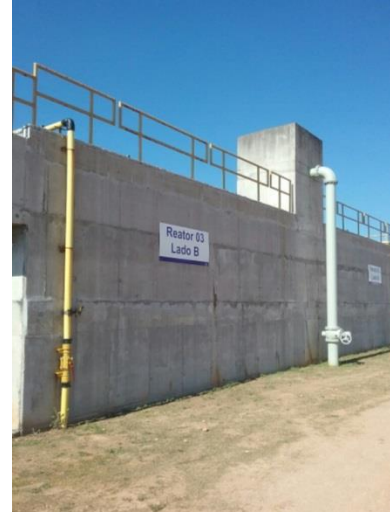
Figura 102. Vista do Reator Anaeróbio.
