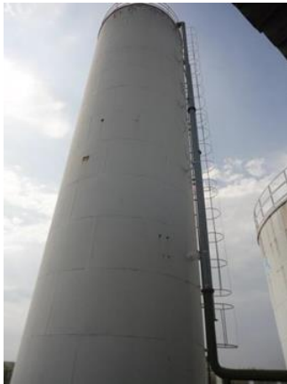
Figura 70. Reservatório Elevado EAT Jardim Panorama.
