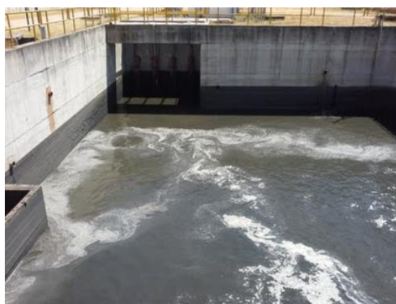
Figura 100. Vista do Tanque de Equalização de efluente.
