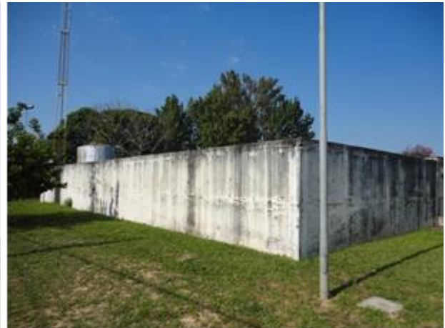
Figura 64. Reservatório Semienterrado EAT João Jabour.
