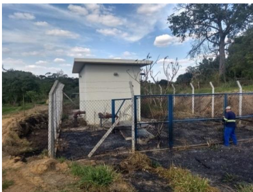
Figura 127. Estação Elevatória de Esgoto – Vila Martins - Vista 1.
