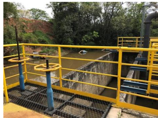
Figura 20. Vista Geral da Captação João Jabour.
