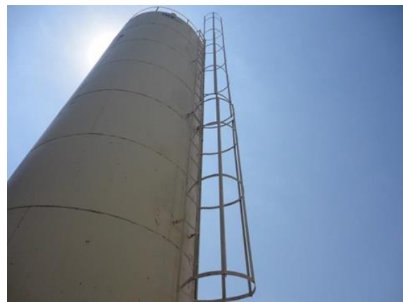
Figura 75. Reservatório Elevado Novo EAT Buru.
