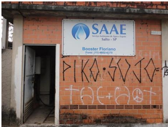
Figura 88. Vista Geral do Booster Floriano.
