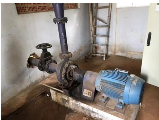
Figura 31. Conjunto motor bomba para o abastecimento do Reservatório Elevado.
