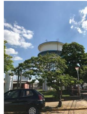
Figura 30. Reservatório Elevado – EAT Hospital.
