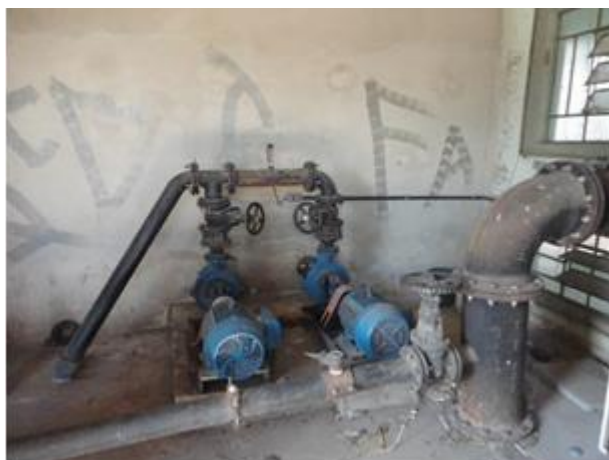
Figura 65. Recalque dos dois conjuntos motor - bomba do EAT João Jabour.
