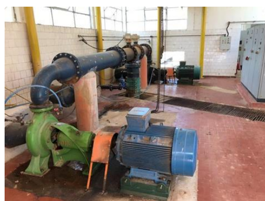
Figura 16. Vista Geral do barrilete de recalque da captação.
