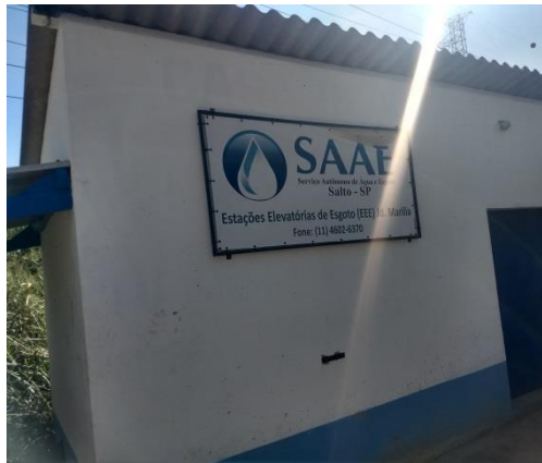
Figura 110. Estação Elevatória Jardim Marília.
