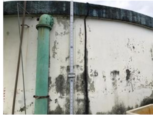
Figura 36. Reservatório Apoiado EAT Nova Era.
