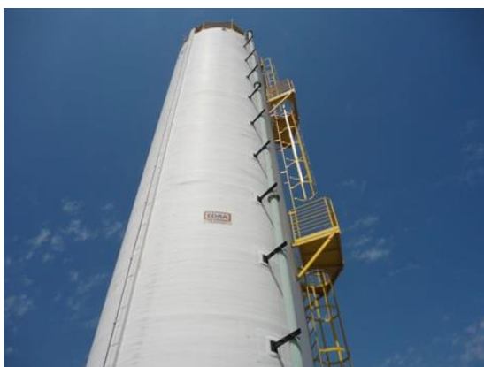
Figura 81. Reservatório Elevado EAT Portal dos Bandeirantes.
