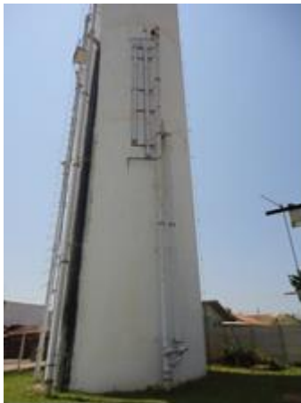
Figura 41. Reservatório Elevado EAT Santa Cruz.
