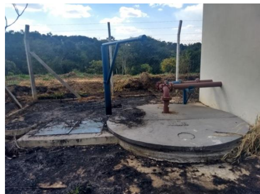
Figura 128. Estação Elevatória de Esgoto – Vila Martins - Vista 2.
