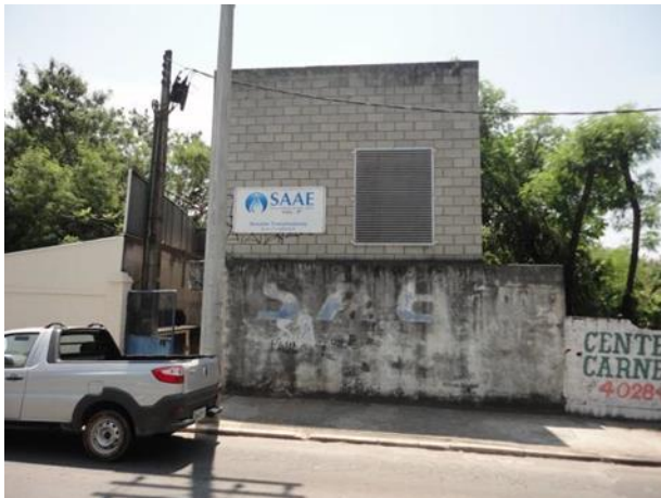
Figura 45. Vista Geral do Booster dos Trabalhadores.
