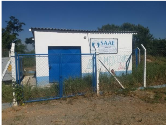
Figura 112. Estação Elevatória – Santa Efigênia.
