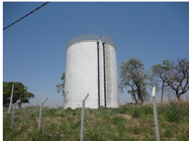
Figura 86. Reservatório Apoiado EAT Vila Martins.
