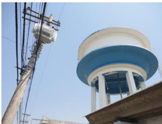
Figura 49. Reservatório Elevado EAT Jardim Cidade (Siemens).
