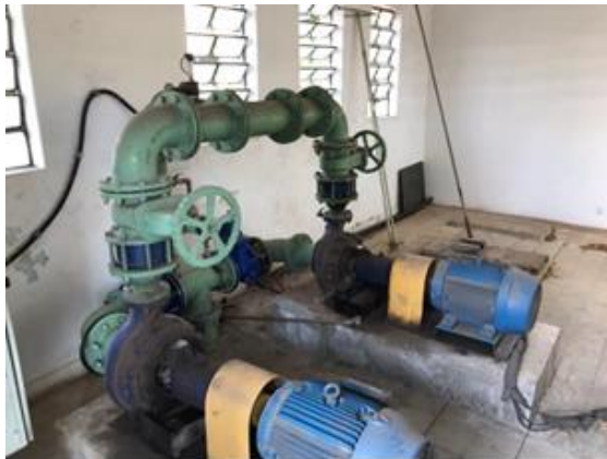
Figura 53. Conjuntos motor - bomba do EAT Prefeitura.
