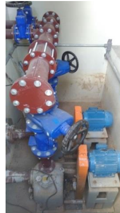
Figura 130. Estação Elevatória de Esgoto – Vila Martins - Vista 4.
