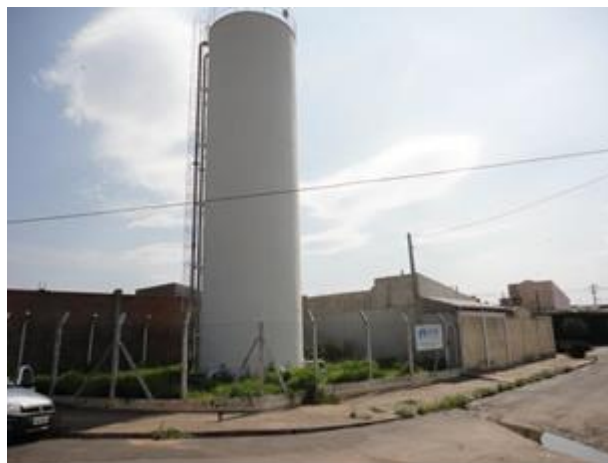
Figura 67. Vista do Reservatório Elevado EAT Santa Marta.
