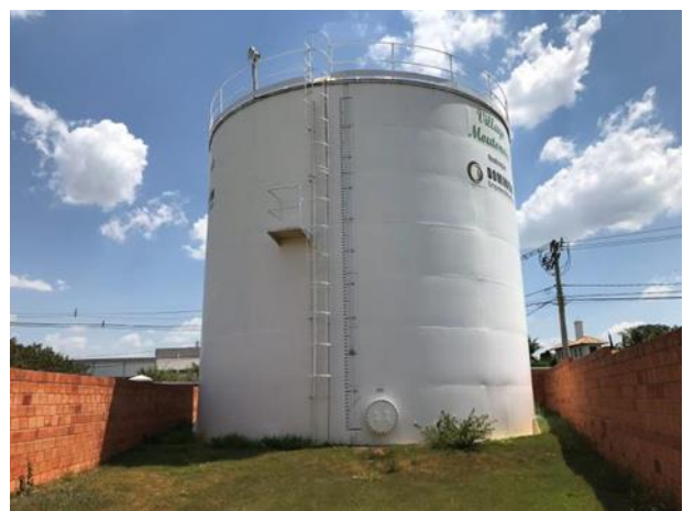
Figura 84. Reservatório Apoiado EAT Moutonnée.
