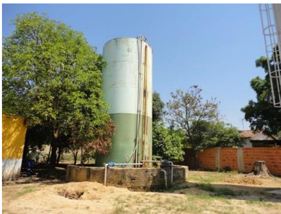
Figura 74. Reservatório Elevado antigo EAT Buru.
