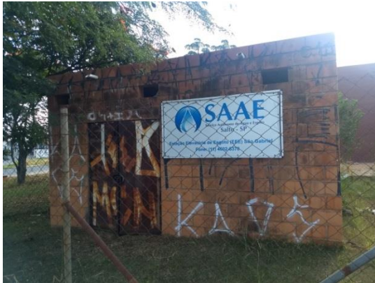
Figura 118. Estação Elevatória de Esgoto – São Gabriel – Vista 1.
