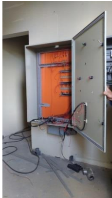
Figura 129. Estação Elevatória de Esgoto – Vila Martins - Vista 3.
