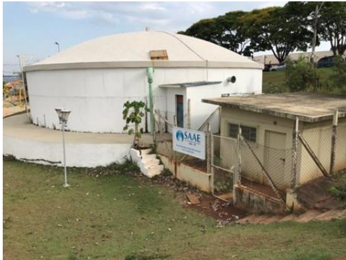
Figura 29. Reservatório Apoiado – EAT Hospital.
