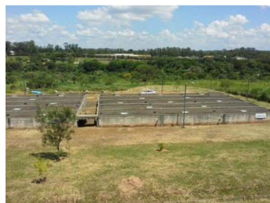
Figura 106. Vista do sistema de Biofiltros.
