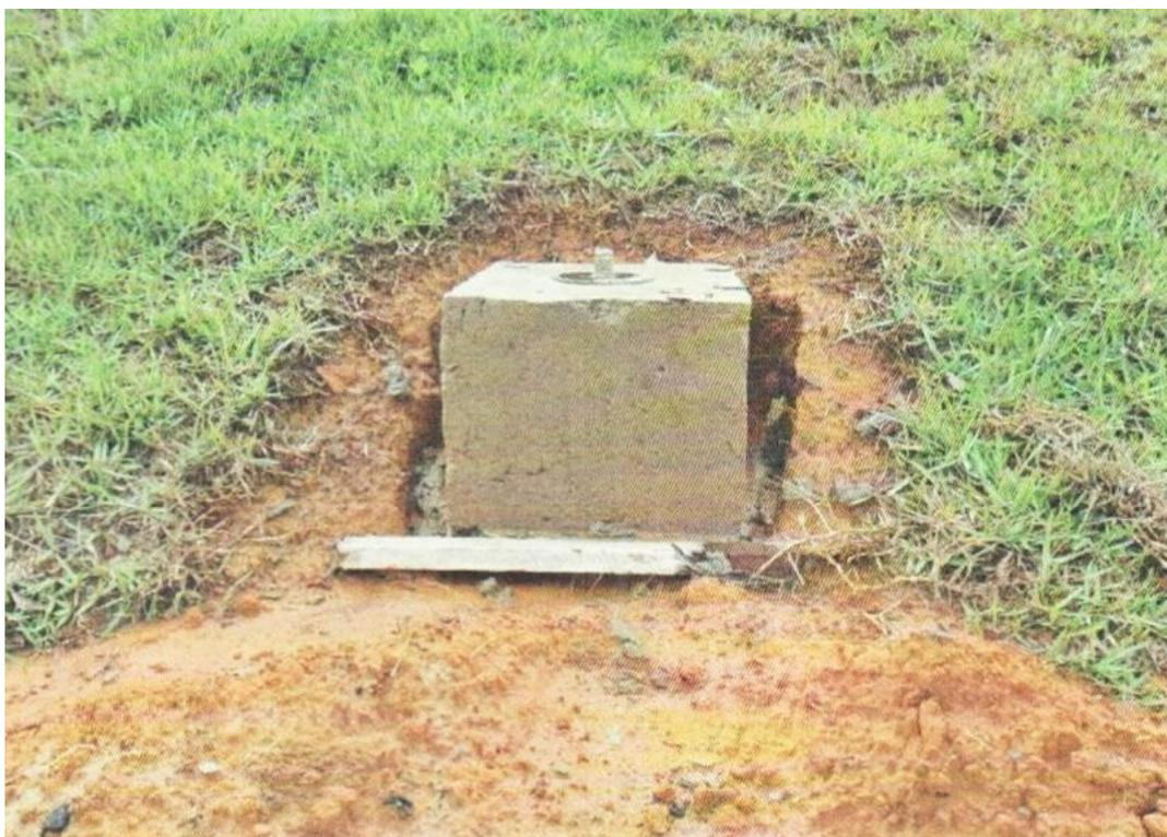
Figura 53 - Instalação de marcos de deslocamento. Fonte: CORPUS.
