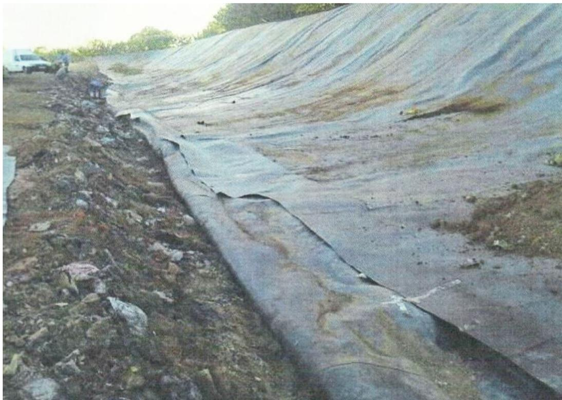
Figura 56 - Obra de impermeabilização com geomembrana PEAD. Fonte: CORPUS.
