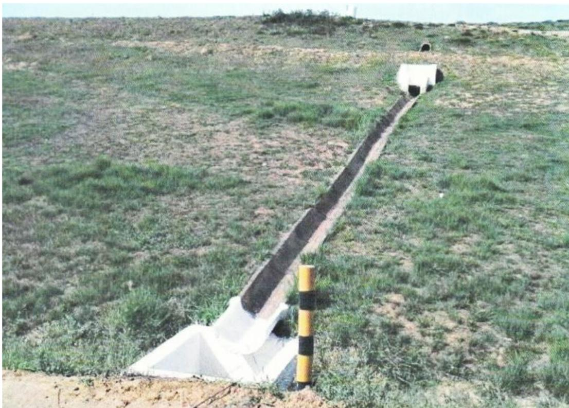
**Figura 58 - Canaletas de drenagem. Fonte: CORPUS.**
