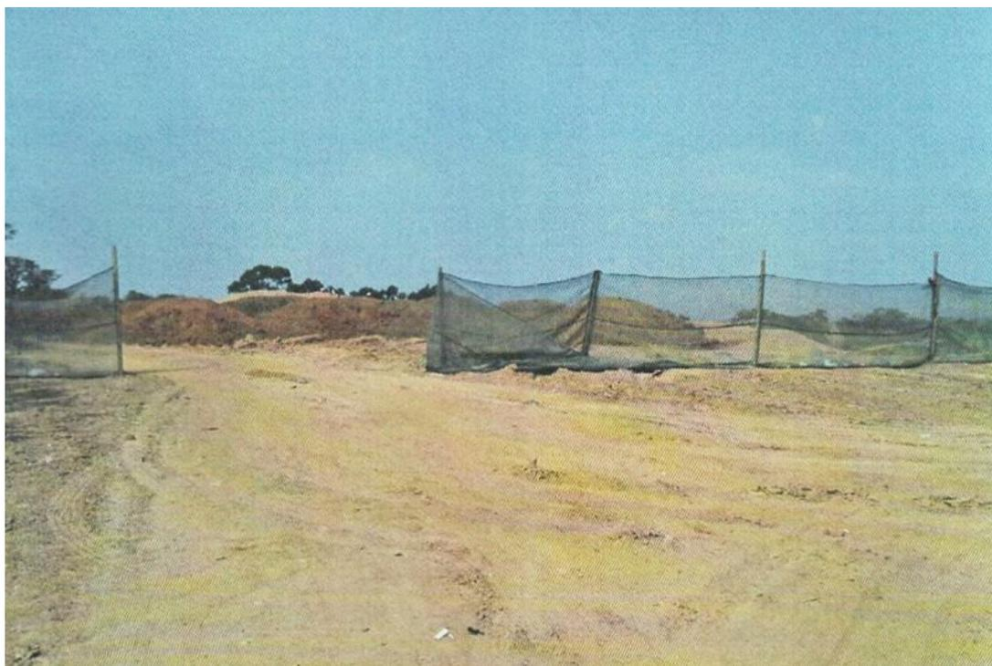
Figura 55 - Depósito de terra para cobertura diária. Fonte: CORPUS.
