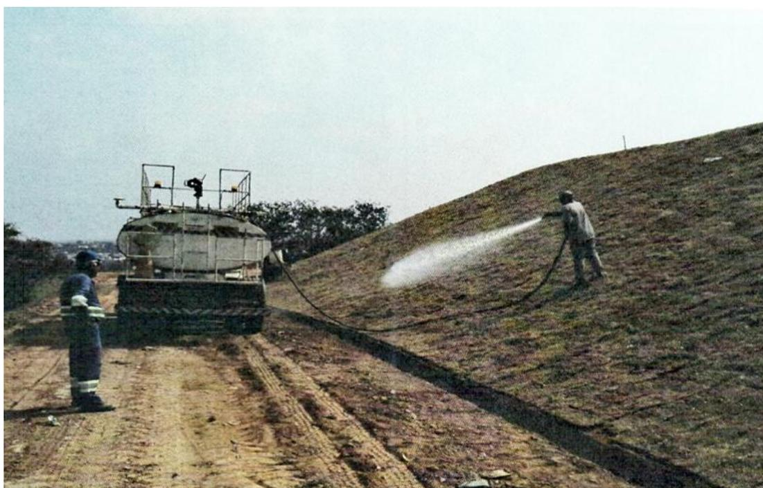
Figura 49 - Plantio de gramas no talude. Fonte: CORPUS.
