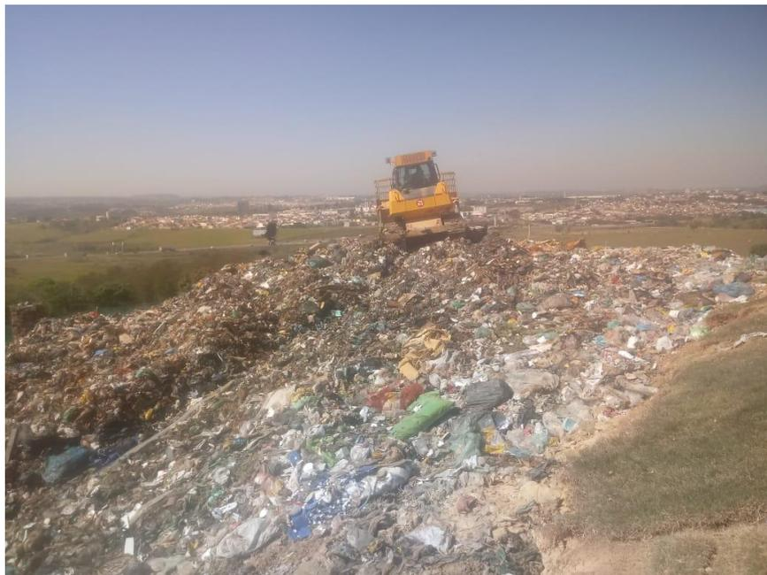
**Figura 54 - Compactação com trator de esteira na frente de descarga. Fonte: CSO Ambiental, 2019.**
