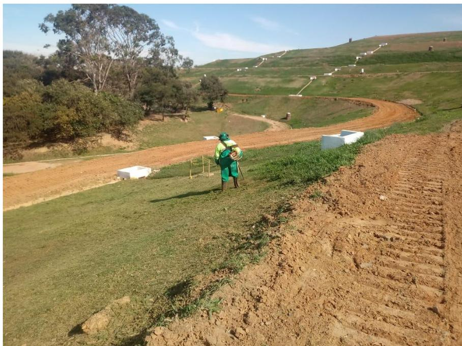
**Figura 57- Roçada mecanizada para manutenção dos taludes. Fonte: CSO Ambiental, 2019.**
