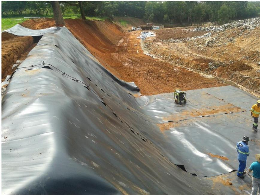
**Figura 56 - Obra de impermeabilização com geomembrana PEAD. Fonte: CSO Ambiental, 2019.**
