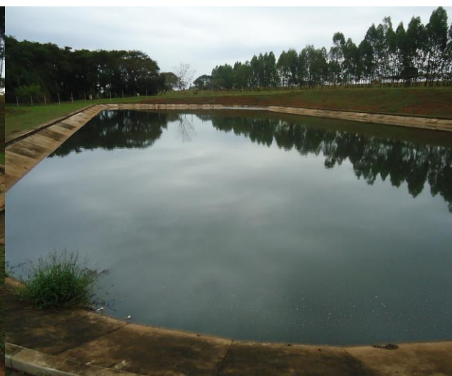
Foto 3.17 – Vista da Lagoa Facultativa
