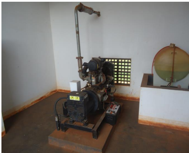
Foto 3.12 – Motor do Conjunto Motobomba – FLYGT HT 3127
