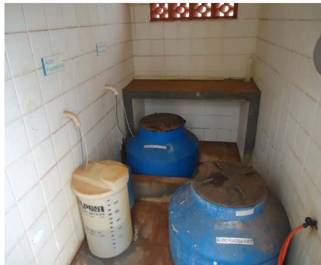
Foto 3.8 – Unidades de Fluoretação e Cloração
