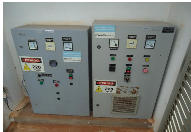
Foto 3.2 – Painel de Controle: PPS 02 e Booster
