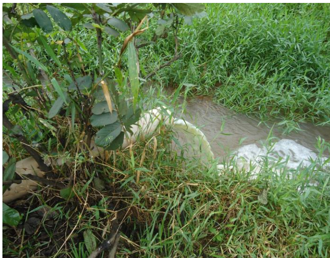
Foto 3.20 – Vista do Lançamento do Efluente Tratado no Corpo Receptor
