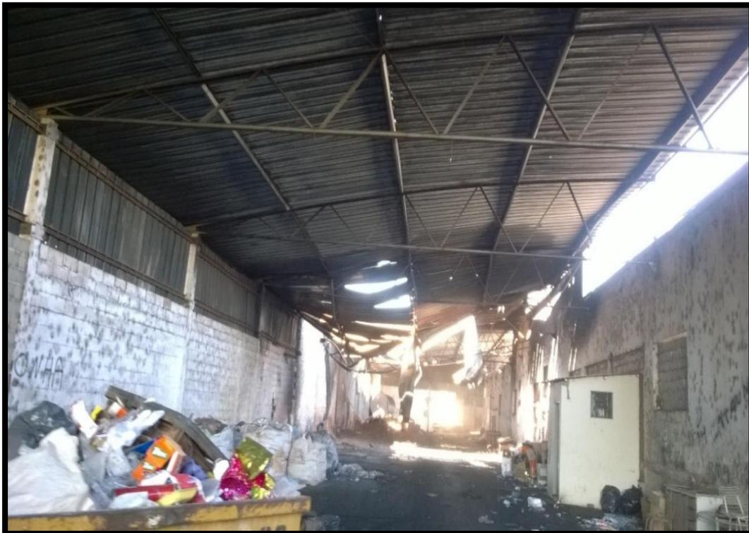
Imagem 54 - Cobertura do centro de triagem após o incêndio
