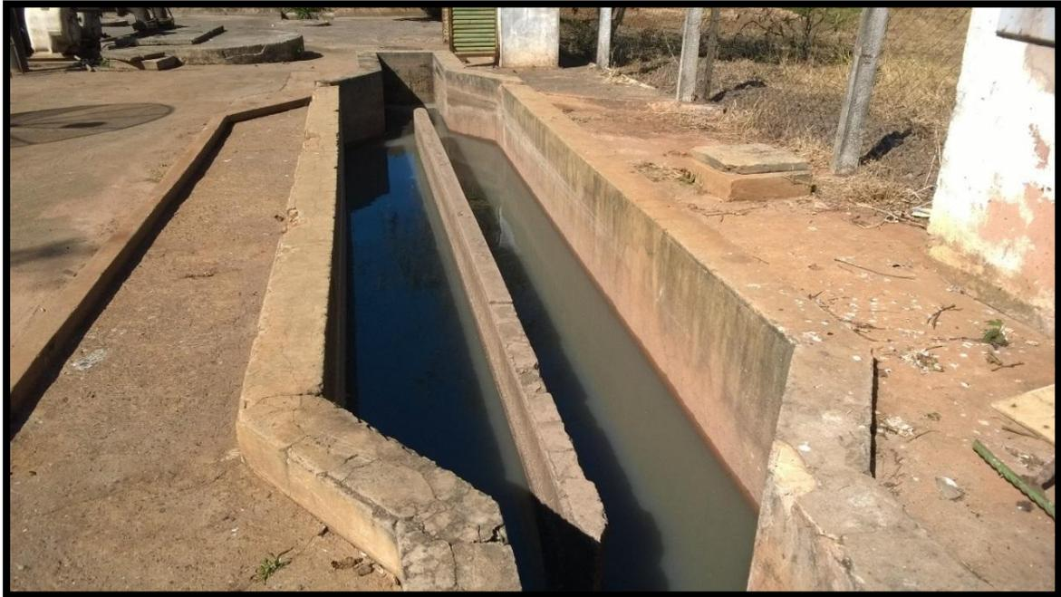
Imagem 30 - Caixa de areia da Estação Elevatória de Esgoto I
