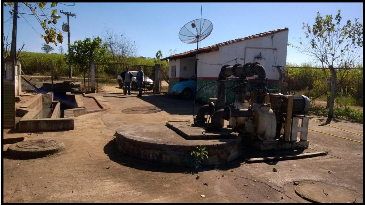
Imagem 32 - Bombeamento da Estação Elevatória de Esgoto I
