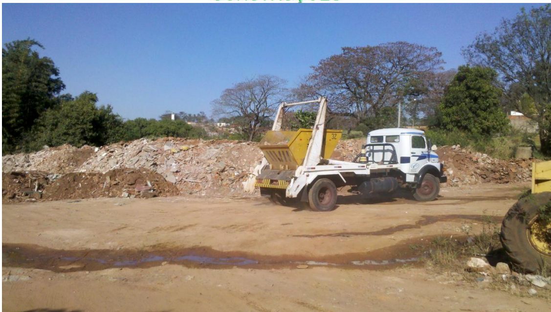
Figura 20 – Local onde é depositado os RCC
