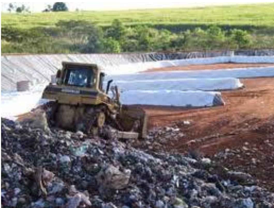
Figura 07 – Centro de Gerenciamento de Resíduos – CGR Catanduva
