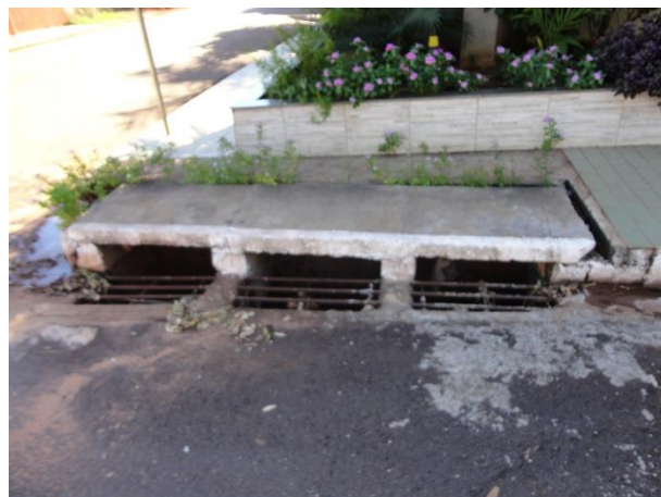
Foto 3.4- Boca de lobo tripla na Av. Sílvio Ralio
