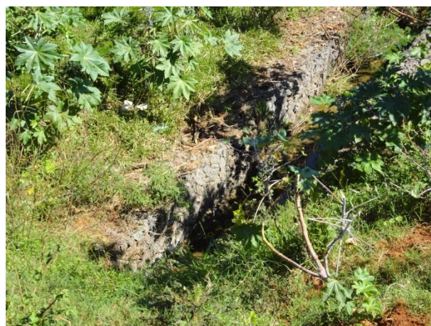
Foto 3.8 – Canal executado com gabião no ponto de lançamento 7.
