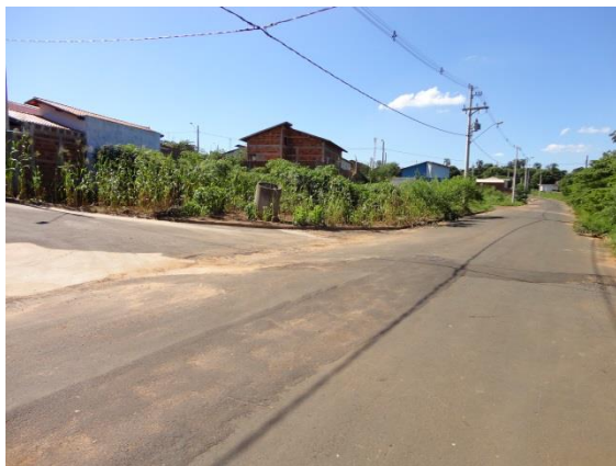
Foto 3.9 – Ponto de alagamento devido a falta de captação.
