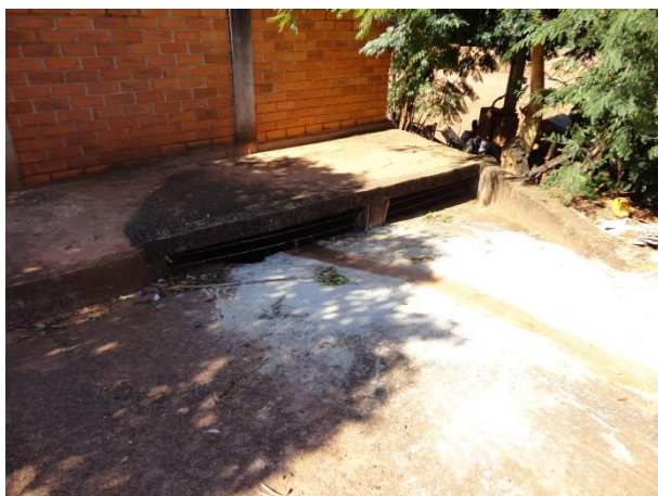
Foto 3.5 – Captação na rua Gabriel Gonzales
