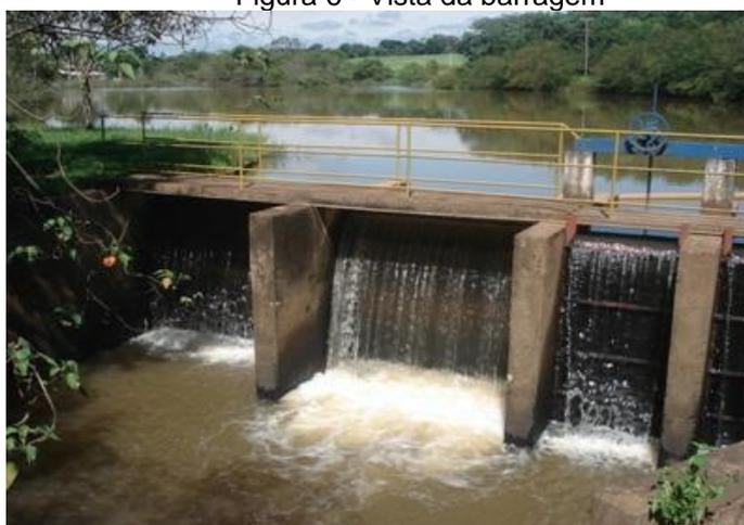
Do lado da barragem encontra-se o canal de tomada de concreto, que possui duas grades metálicas para retenção de sólidos grosseiros, a qual se encontra automatizada.
