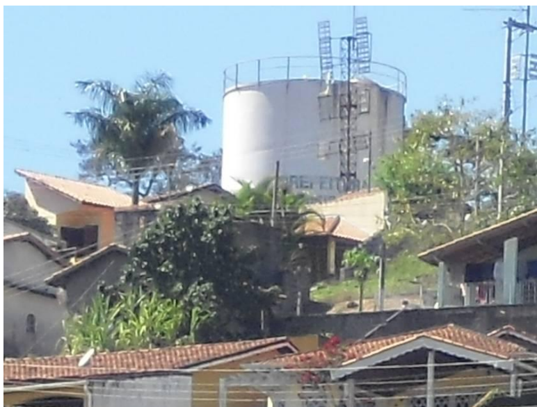
Foto 06 – Reservatório Nova ETA de 500m 3 que abastece a Zona Alta.
