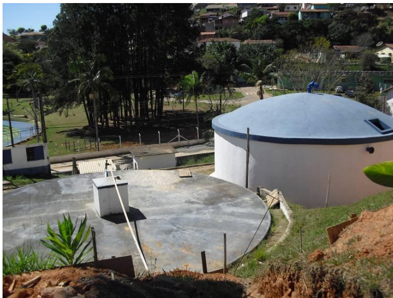
Foto 05 – Vista Geral dos Reservatórios Existentes na Área da ETA.
