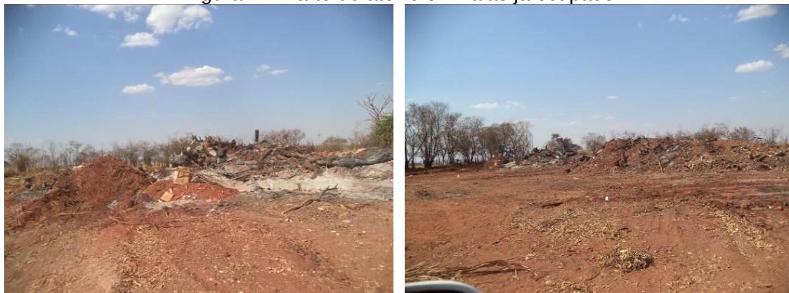
Figura 74. Parte do aterro em valas já ocupado
