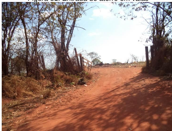
Figura 81. Entrada do aterro em valas
