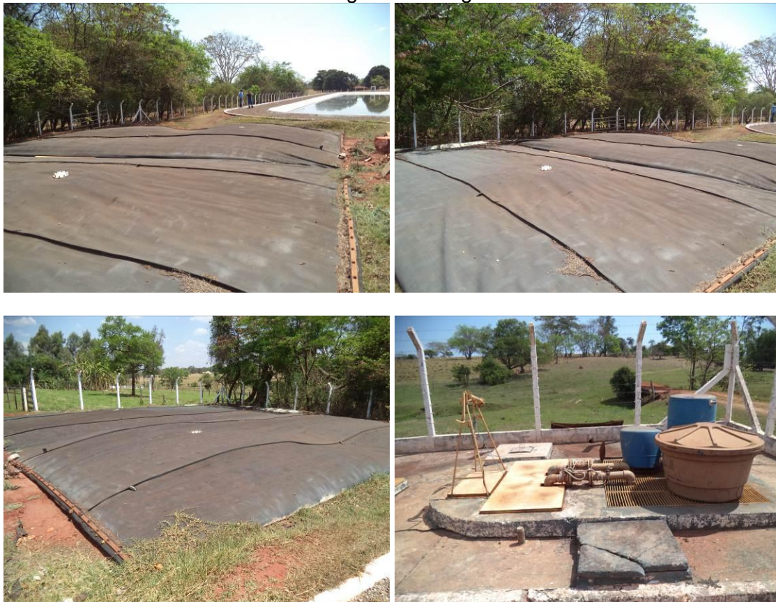
Figura 133. Resíduo provenientes do gradeamento e limpeza da ETE, armazenados em bag e caixa d'agua
