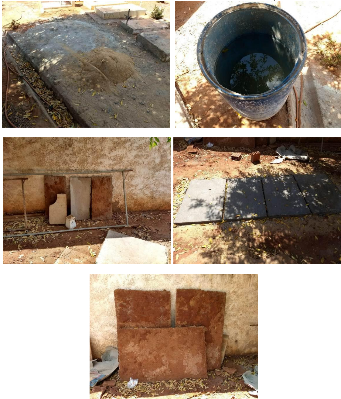
Figura 97. Fachada do cemitério, resíduos resultantes da limpeza de túmulos, área do cemitério, instrumentos de trabalho e materiais da construção civil
