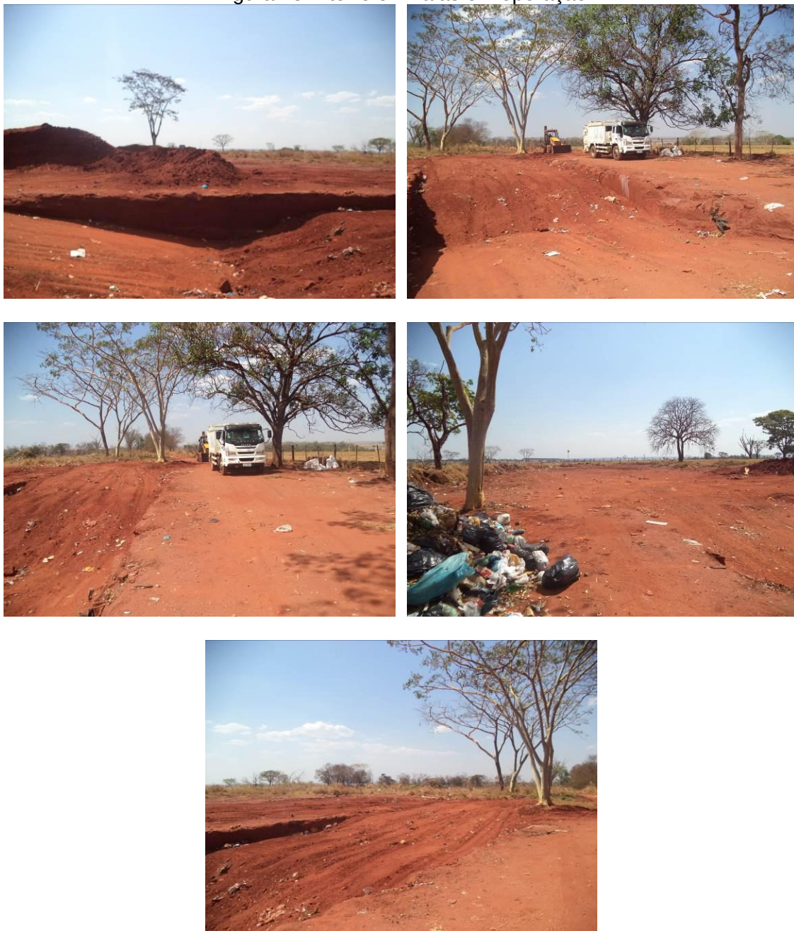
Figura 78. Aterro em valas em operação
