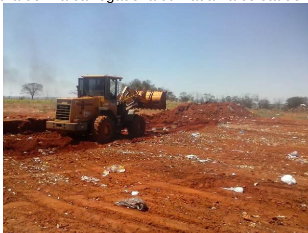
Figura 95. Pá carregadeira utilizada na coleta de RCC
