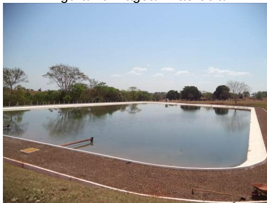
Figura 40. Lagoa Anaeróbia
