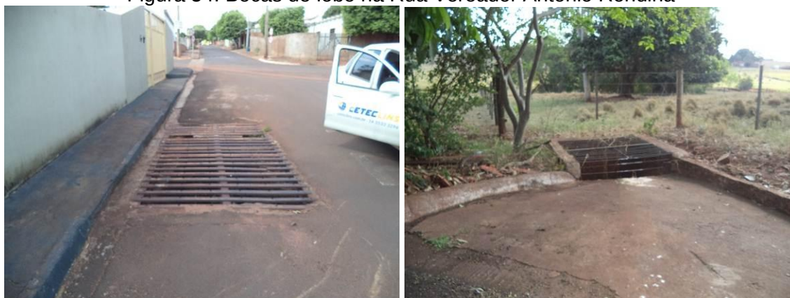
Figura 54. Bocas de lobo na Rua Vereador Antônio Rondina
