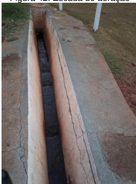
Figura 42. Escada de aeração
