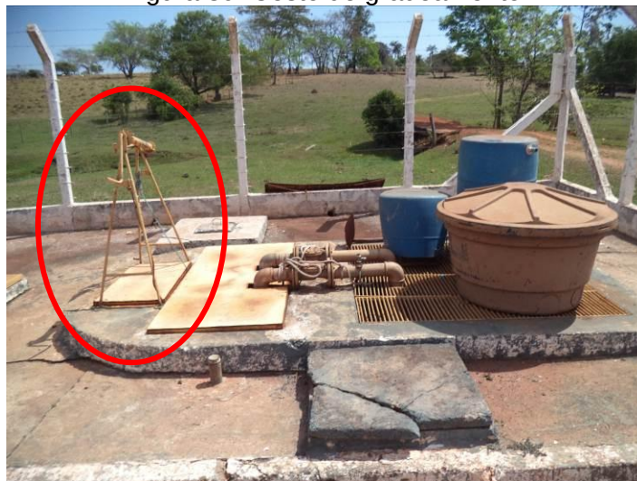
Figura 39. Cesto de gradeamento.
