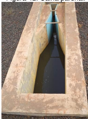
Figura 41. Calha parshall
