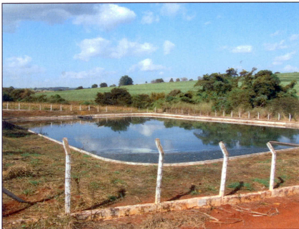
Figura 8 - Vista aérea parcial da área ETE.
