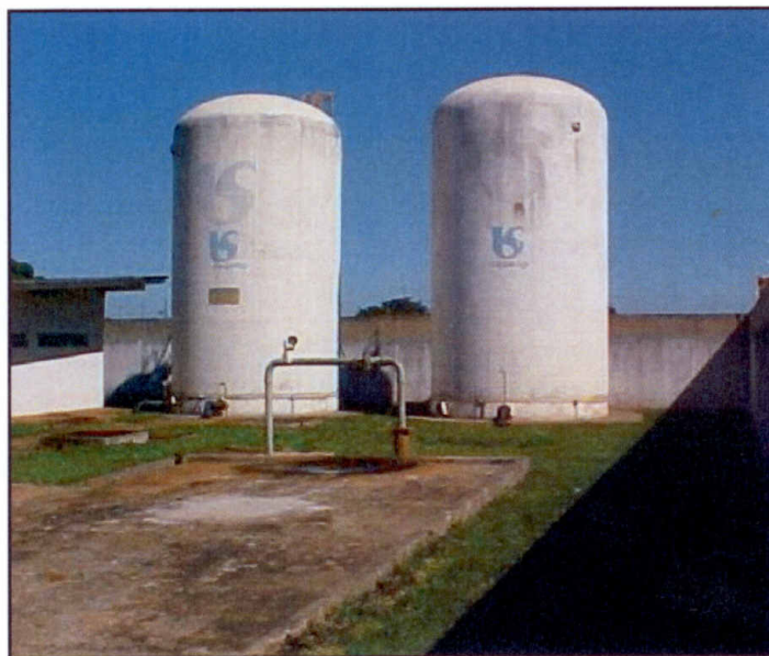
Figura 4 - Vista cavalete do poço P01.
