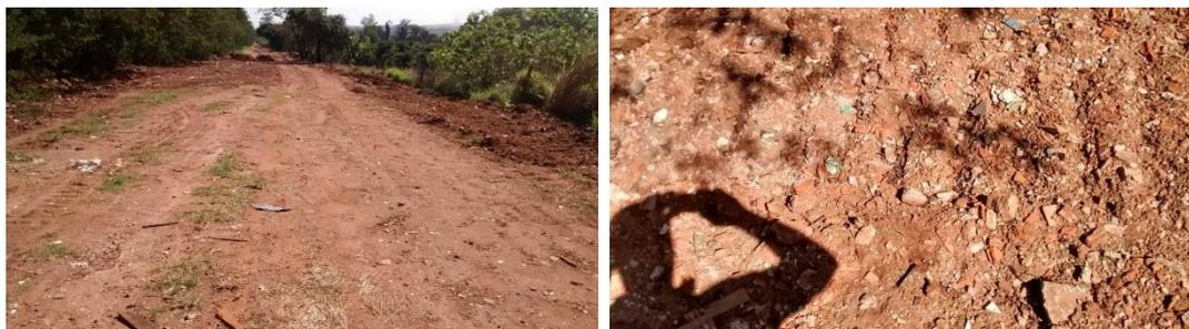
Figura 45 e 46 - Uso dos resíduos da construção civil na recuperação de estradas rurais.
