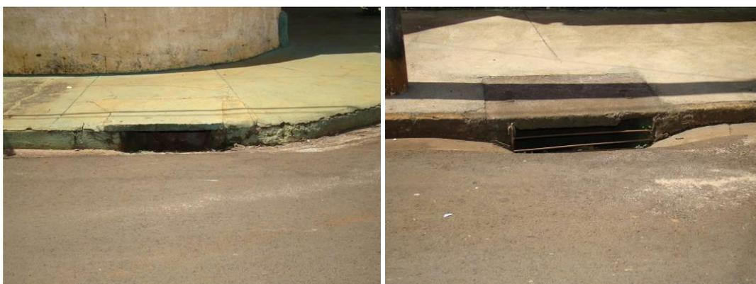
Figura 29 e 30 – Boca de lobo simples em bom funcionamento com gradeamento à direita, contrapondo com a figura à esquerda, que exibe uma boca de lobo simples com abertura muito pequena em relação ao volume de água a ser drenado.
