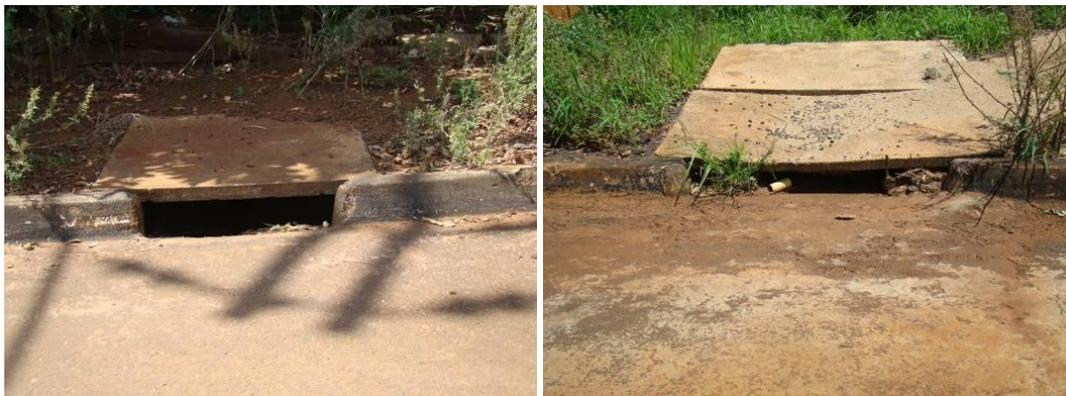
Figura 27 e 28 – Crescimento de gramíneas na entrada do dispositivo de drenagem à direita e boca de lobo simples a esquerda.
