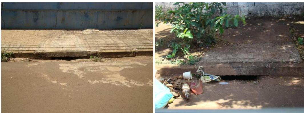
Figura 23 e 24 – Boca de lobo simples apresentando deficiência de escoamento, facilitando o entupimento das mesmas.
