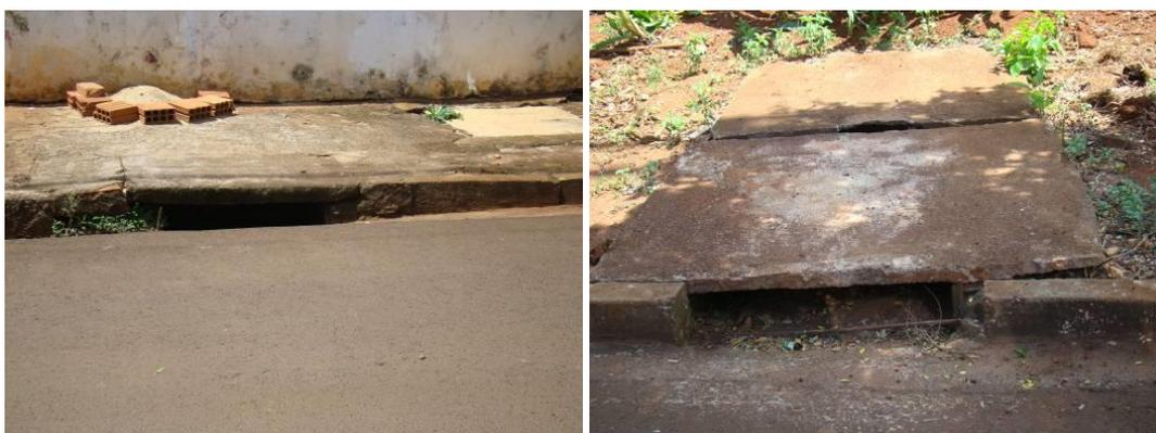
Figura 25 e 26 - Drenagem Existente – Boca de lobo simples.
