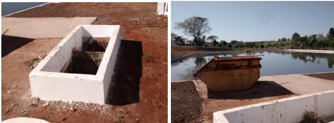
Figura 60 e 61 - Sistema de Tratamento Preliminar (Grade de contenção de sólidos grosseiros) e caçamba para disposição dos resíduos provenientes da limpeza da grade.
