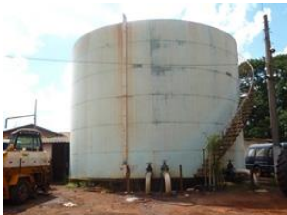
Foto 4.39 – Reservatório Apoiado Almojarifado – R-14
