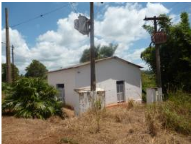
Foto 4.47 – Casa de Bombas da EEAT 3
