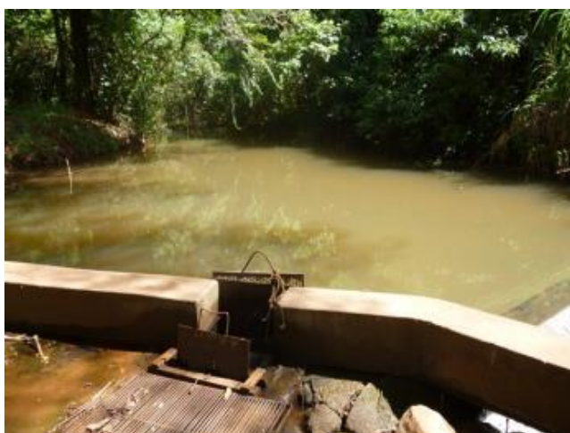
Foto 4.5 – Barragem de Nível I do Ribeirão Tabaranas e Canal com Comportas para EEAB 4
