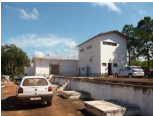
Foto 4.21 – Prédio da ETA Davi
