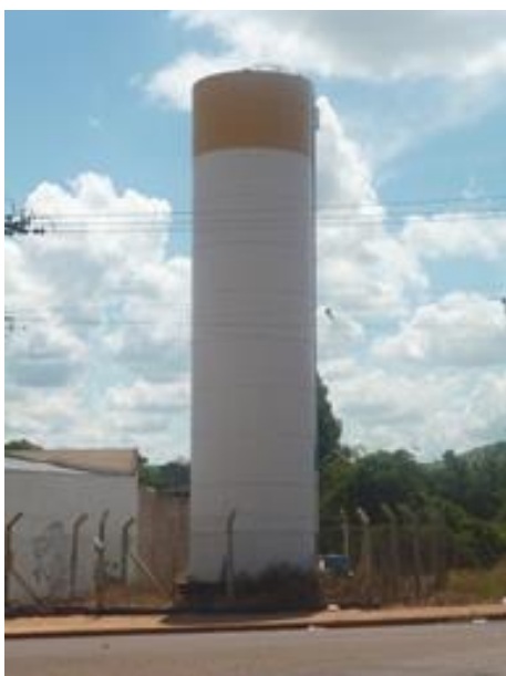
Foto 4.35 – Reservatório Vila Santa Terezinha – R-10
