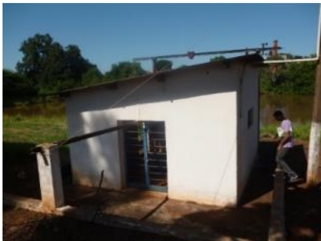
Foto 4.11 – Casa de Bombas da EEAB 1
