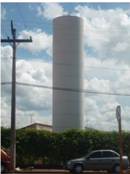
Foto 4.37 – Reservatório Vila Penteado – R-12
