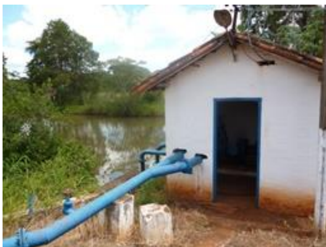
Foto 4.13 – Casa de Bombas da EEAB 2
