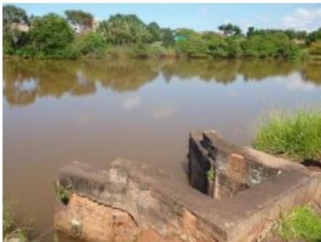
Foto 4.1 – Barragem do Córrego Pessegueiro que abastece o Poço de Sucção da EEAB 1
