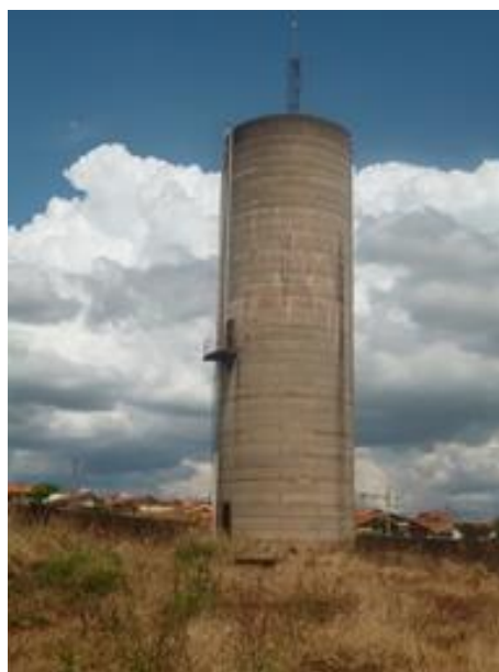
Foto 4.36 – Reservatório Dedine – R-11
