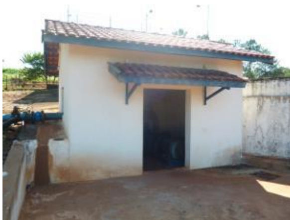
Foto 4.43 – Casa de Bombas da EEAT 1
