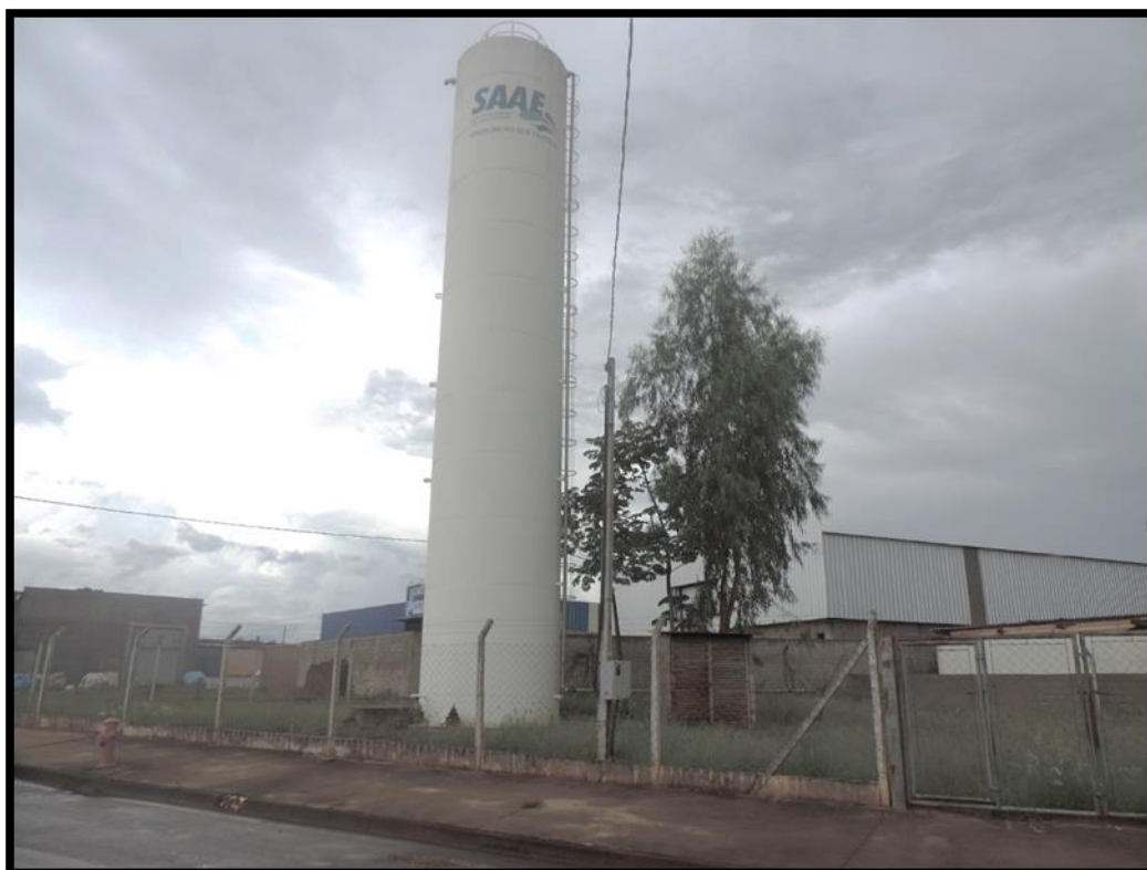
Imagem 8 – Reservatório Europa III
