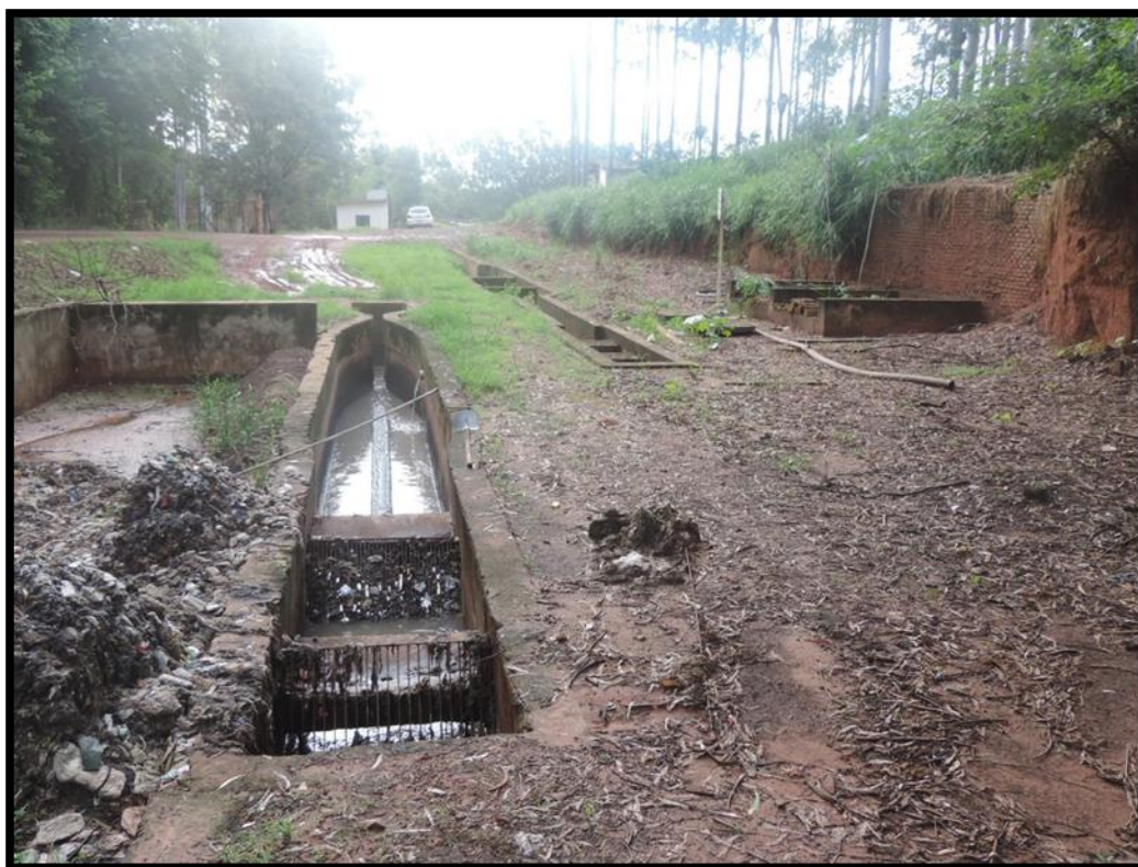
Imagem 43 – vista das duas caixas de areia (antiga e nova)
