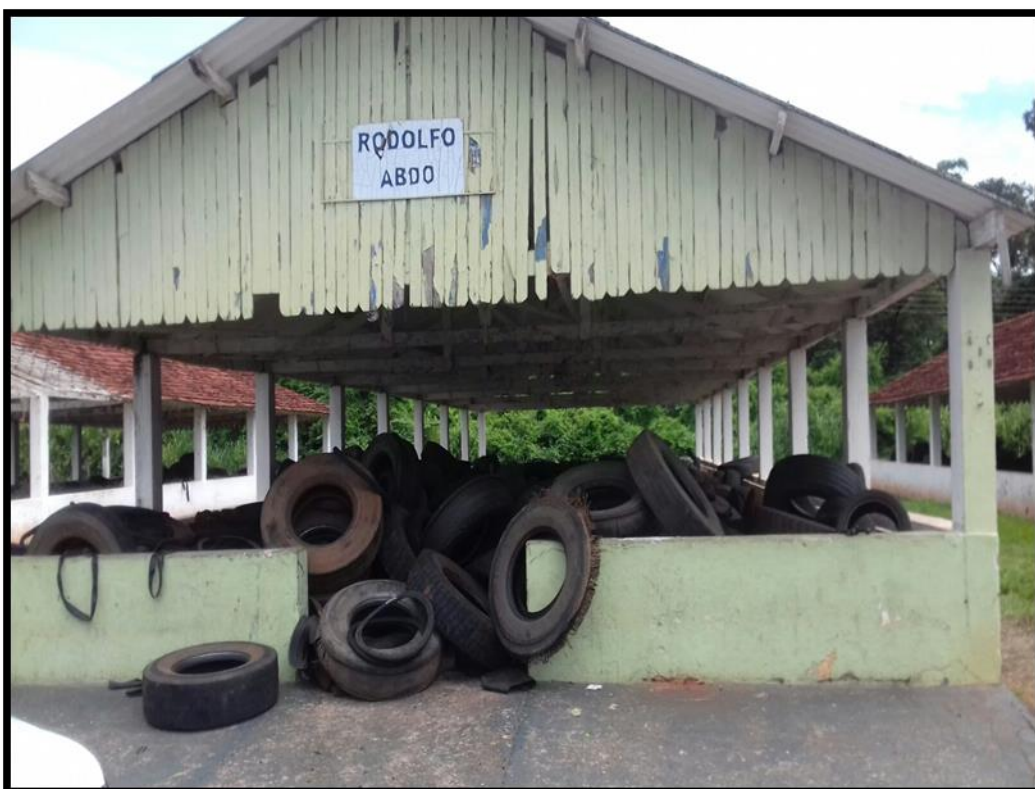
Imagem 114 – Barracão onde são armazenados os pneumáticos
