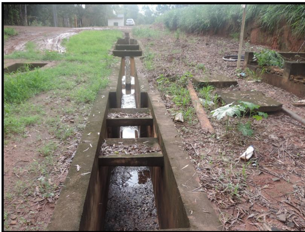
Imagem 42 – Caixa de areia em construção
