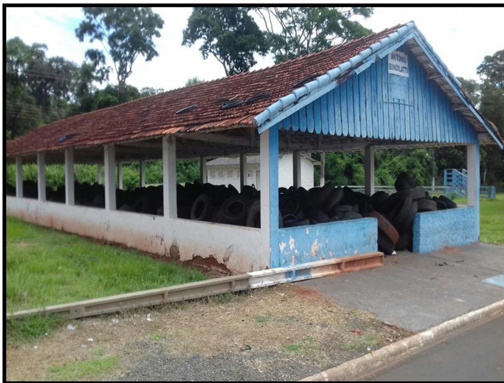
Imagem 115 – Barracão onde são armazenados os pneumáticos
