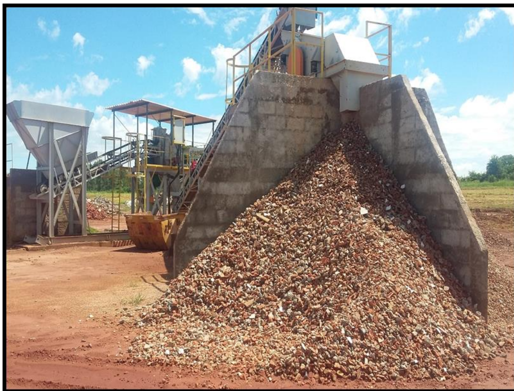
Imagem 94 – Usina de Britagem/Reciclagem de RCC
