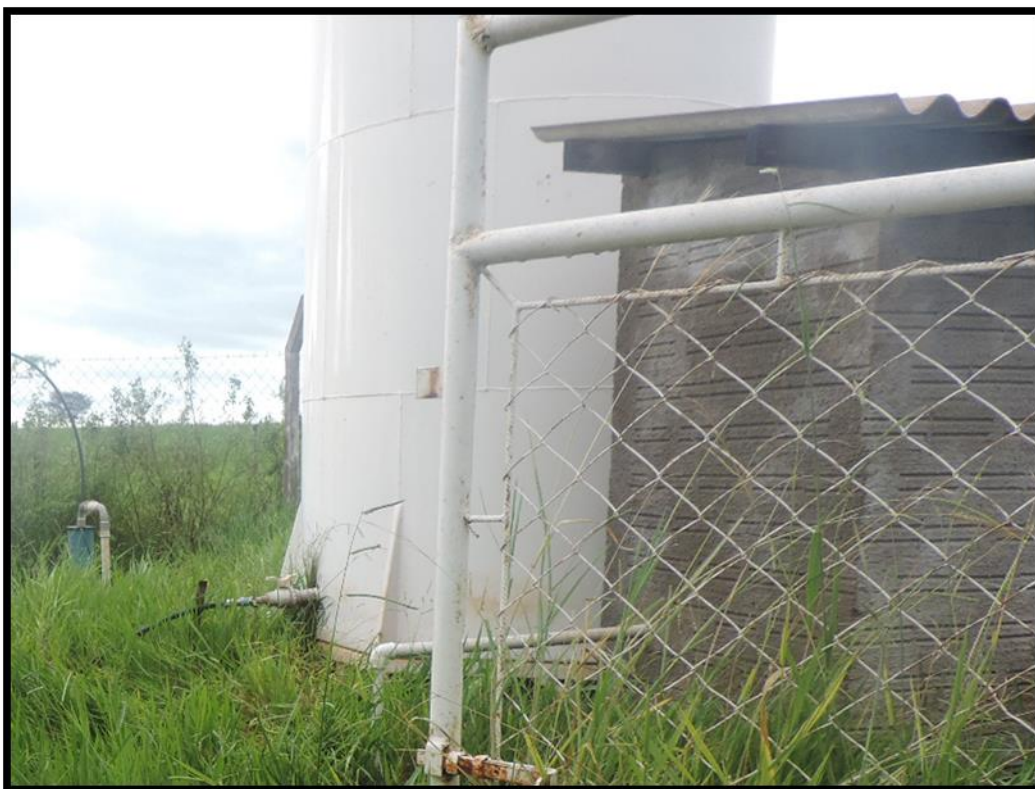
Imagem 15 – Poço Residencial Santa Júlia
