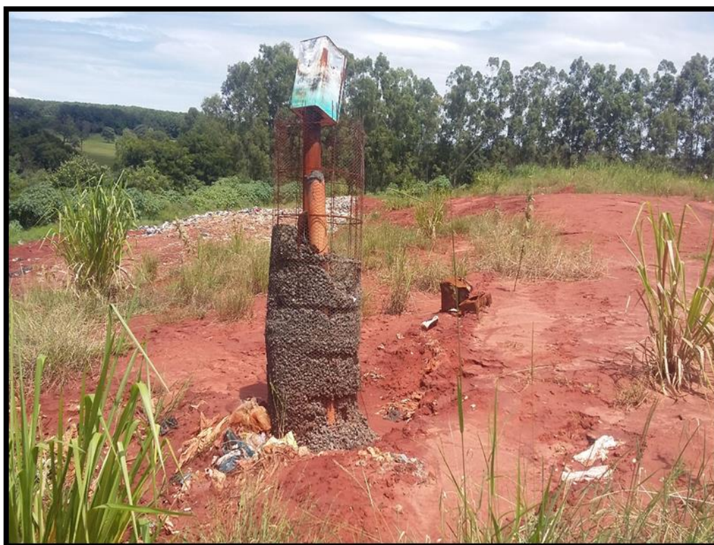
Imagem 86 – Dreno de Gás no Aterro Sanitário
