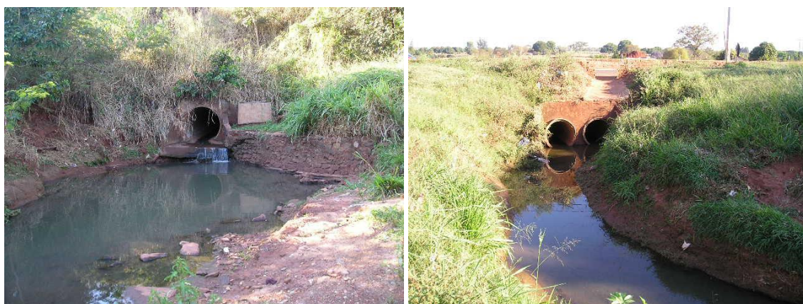
Imagem 53 – Despejo inadequado de águas pluviais à jusante da linha férrea – Ponto crítico 2
