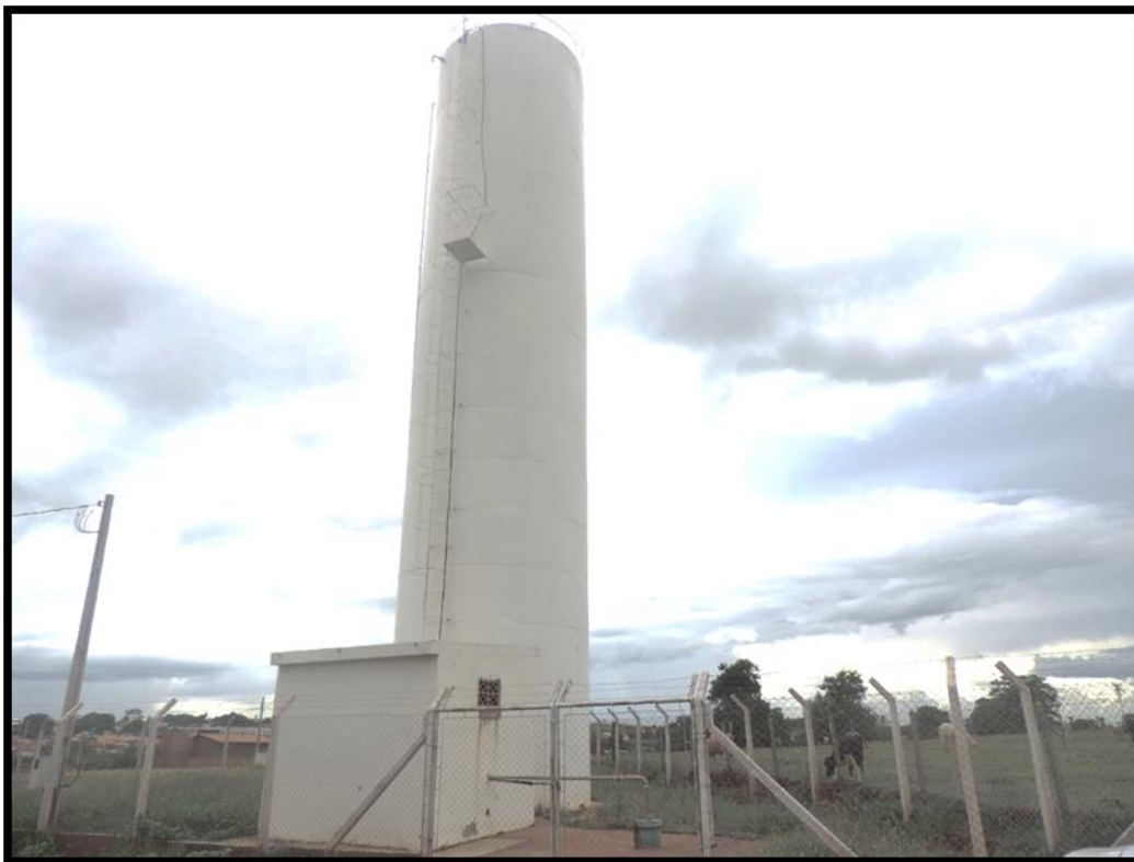
Imagem 14 – Reservatório Vila Lobos
