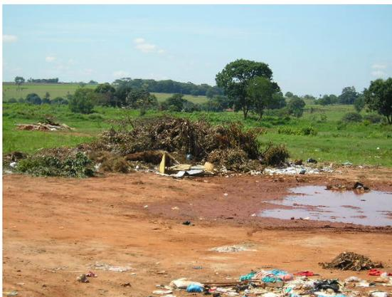
DRENAGEM INADEQUADA NO ATERRO DESATIVADO
