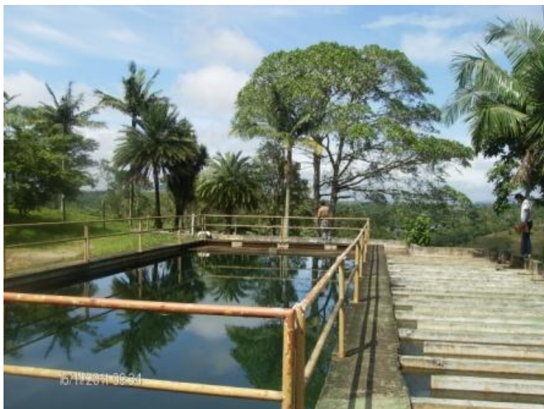
Foto 04 – Unidades de floculação e decantação da ETA-2 (Fonte: Prefeitura Municipal de Santa Isabel)
