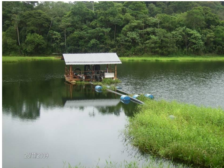
Foto 02 – Captação de Água Bruta no Reservatório do Rio Jaguari (Fonte: Prefeitura Municipal de Santa Isabel)
