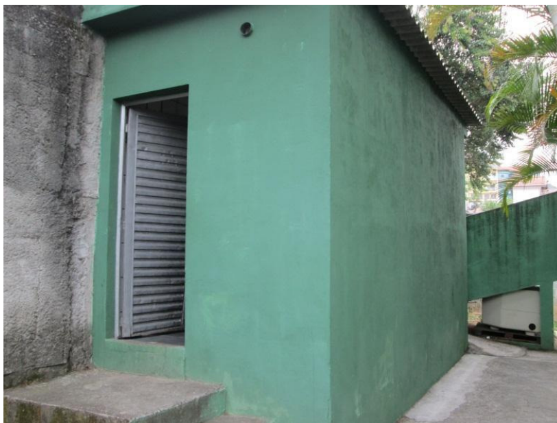
Figura 30: Local para acondicionamento de resíduos hospitalares antes de serem coletados no Hospital Santa Casa.
