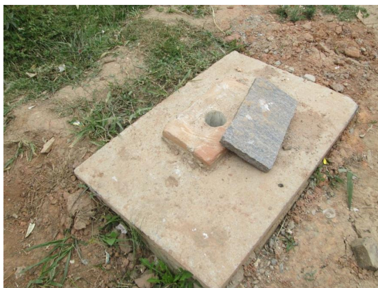
Figura 48: Reservatório de chorume enterrado.
