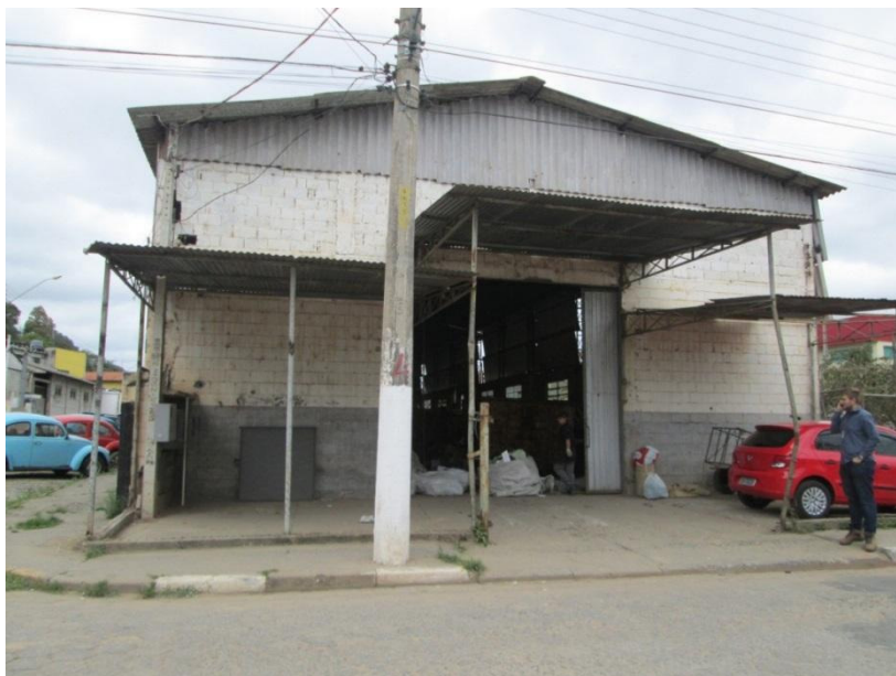
Figura 32: Galpão de Triagem da Associação Cata Papel
