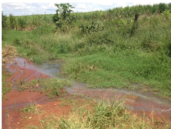
Foto 4.8 - Esgoto a céu aberto, próximo à ETE Monjolinho
