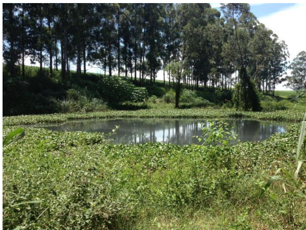
Foto 4.10 - Lagoa anaeróbia da ETE Monjolinho
