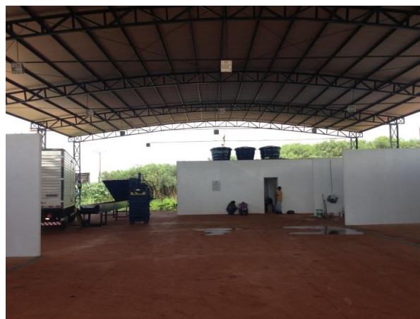
Foto 4.18 - Galpão para reciclagem de lixo
