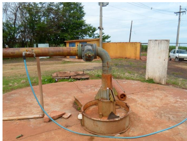
Foto 4.2 - Vista do Poço P4
