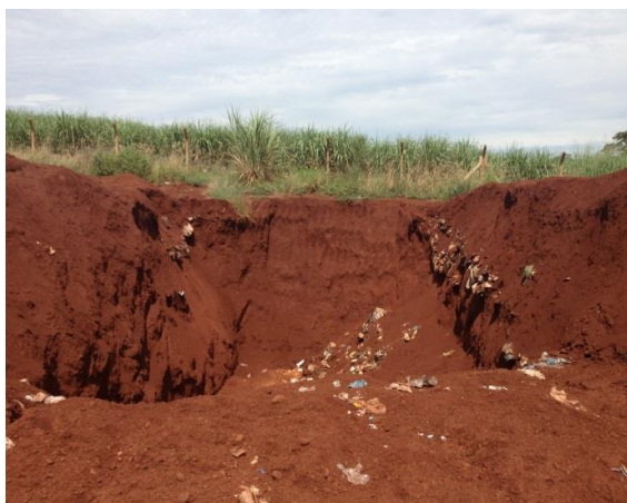
Foto 4.17 - Aterro em Valas
