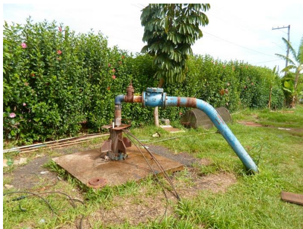
Foto 4.1 - Vista do Poço P3
