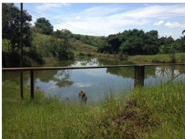
Foto 4.3 - Adutora do P2
