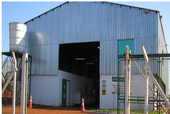
Foto 4.19 - Unidade de Tratamento NGA
