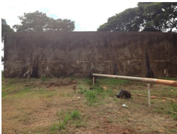
Foto 4.7 - Reservatório desativado próximo ao Reservatório R-P4
