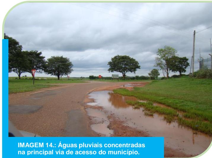
IMAGEM 14.: Águas pluviais concentradas na principal via de acesso do município.
