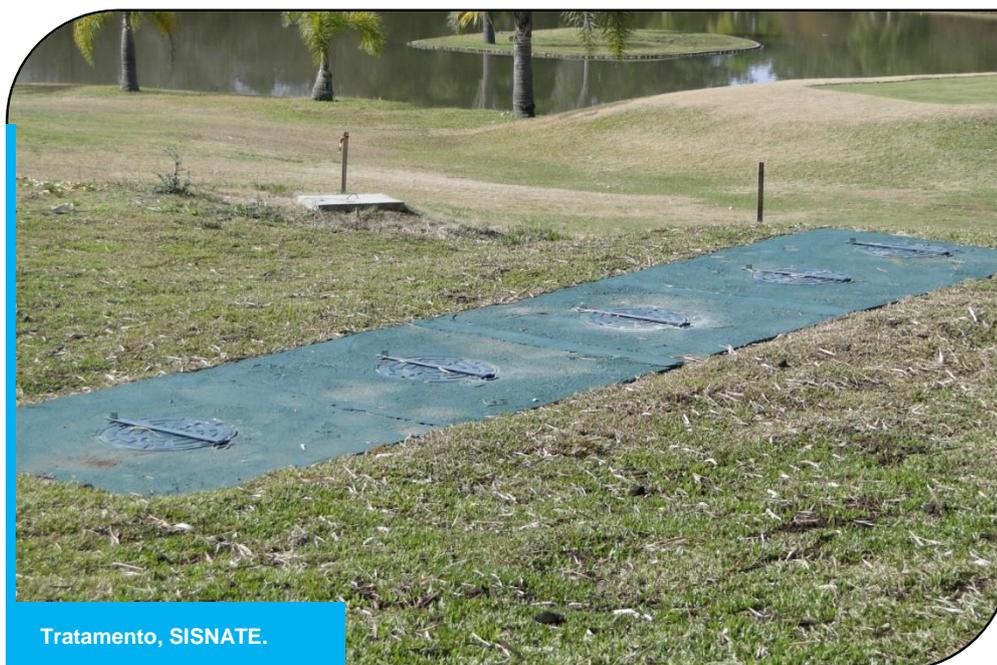
O processo de adsorção e degradação biológica do SISNATE® através da digestão anaeróbica de microrganismos que é a transformação da matéria orgânica em metano e dióxido de carbono através de um sistema complexo em que funciona a macrobiótica sob a falta de oxigênio. Esta técnica consome uma pequena quantidade de energia, produz uma pequena quantidade de lodo e gera um biogás combustível utilizável diretamente na área de produção.
