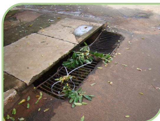
**IMAGEM 07.:** Pressão antrópica no antigo aterro e lixo/folhas impedimento o escoamento das águas pluviais no distrito de Terra Nova D´Oeste.
