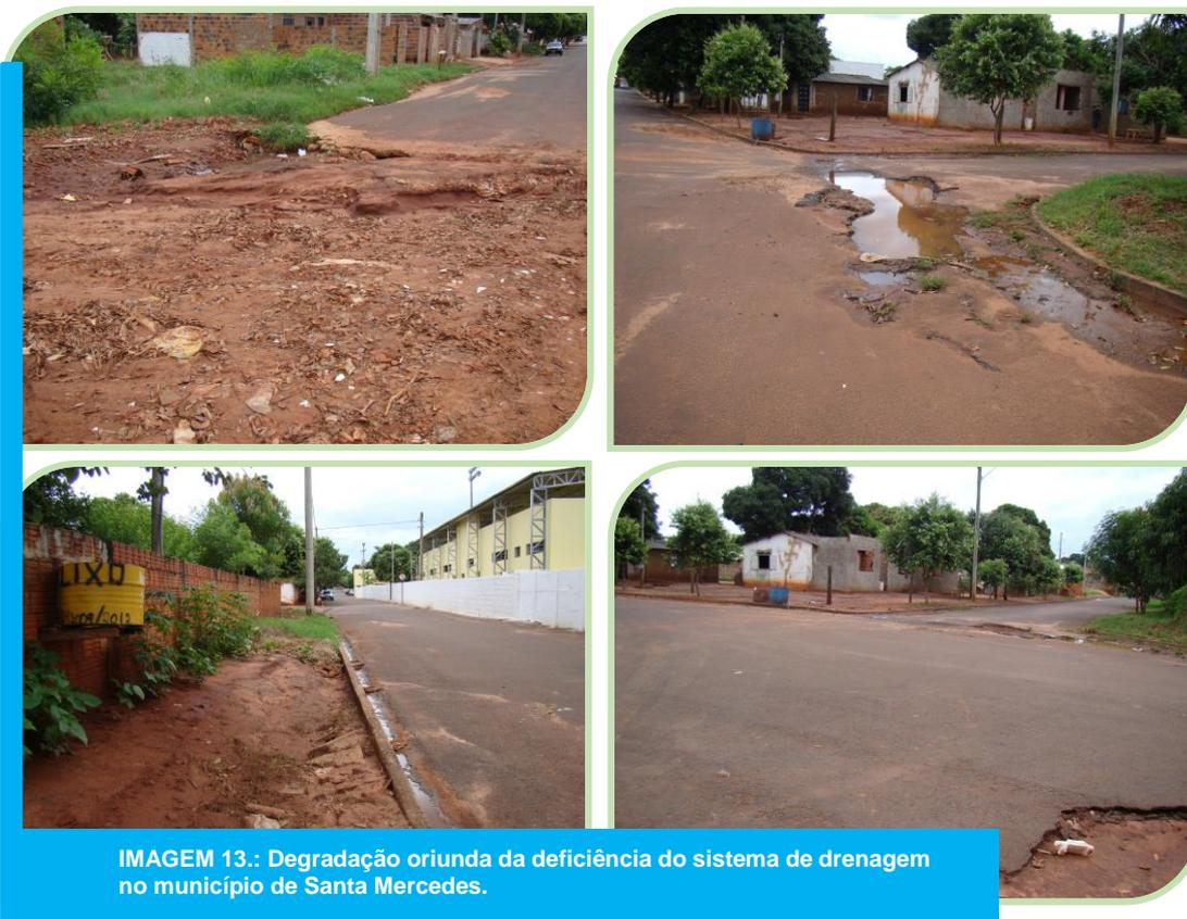
IMAGEM 13.: Degradação oriunda da deficiência do sistema de drenagem no município de Santa Mercedes.
