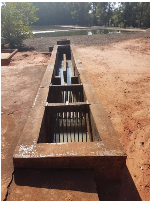
Foto 3.7 - Calha Parshall – Entrada ETE
