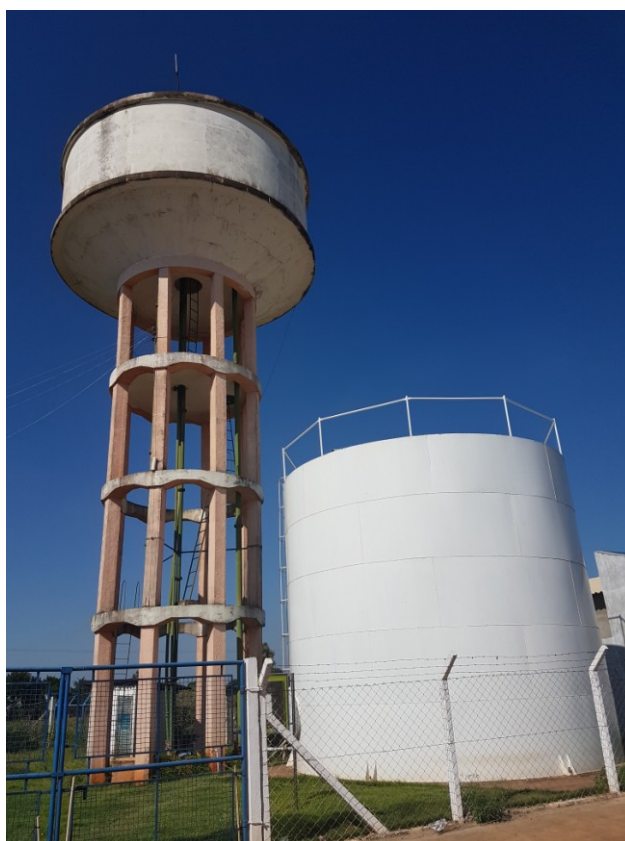
Foto 3.4 – Área dos Reservatórios 1 e 2
