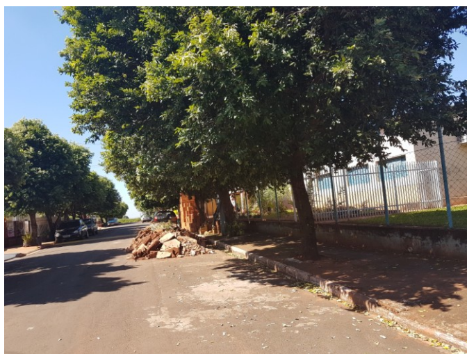
Foto 3.13 – Resíduos de RCC dispostos de maneira inadequada na rua.
