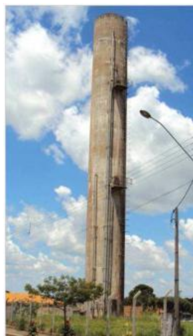
Foto 4.15 – Reservatório Jardim Nova Santa Rita*
