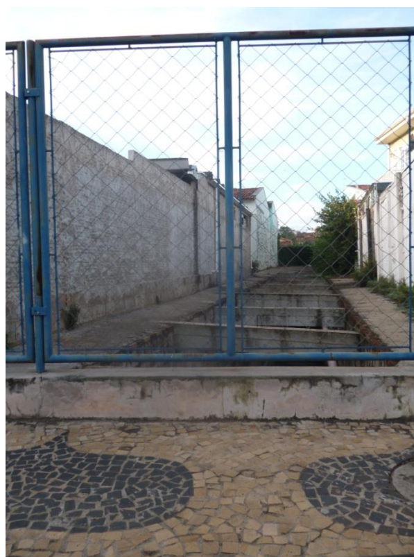
Foto 4.32 – Vista do Canal – Rua Visconde do Rio Branco
