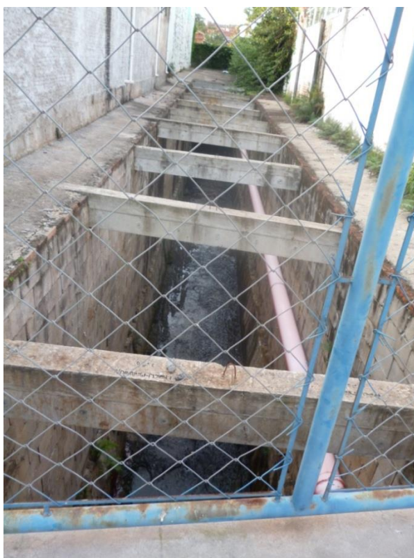
Foto 4.31 – Vista do Córrego – Rua Visconde do Rio Branco
