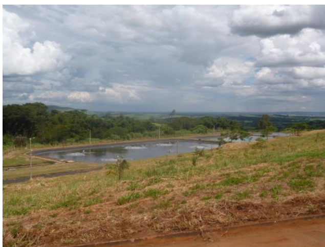
Foto 4.19 - Vista Geral da ETE
