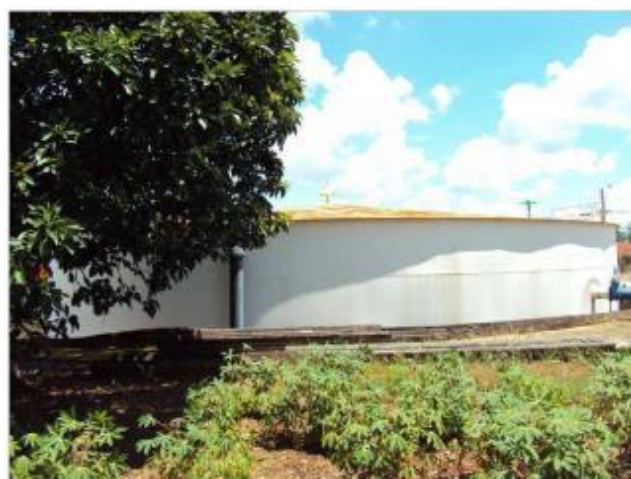
Foto 4.13 – Reservatório Jardim Bonanza 1*
