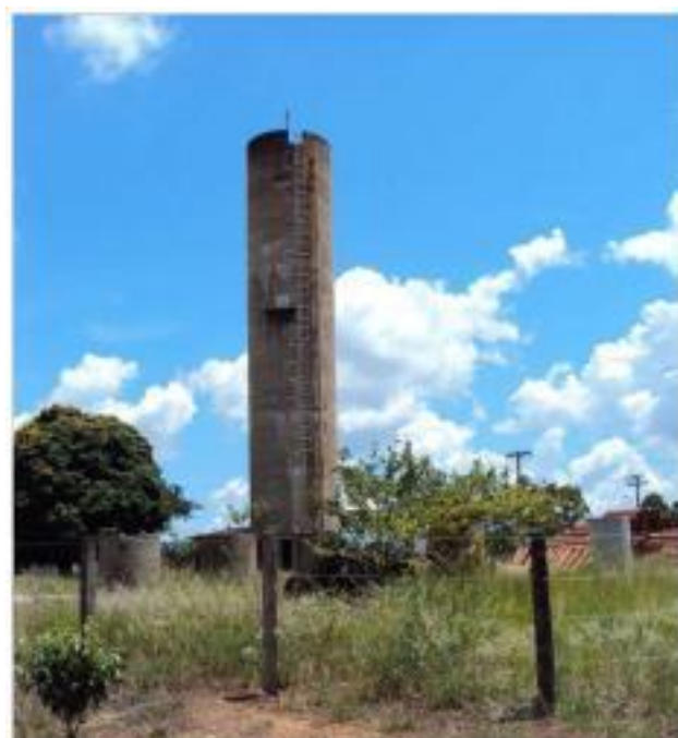
Foto 4.14 – Reservatório Jardim Bonanza 2*
