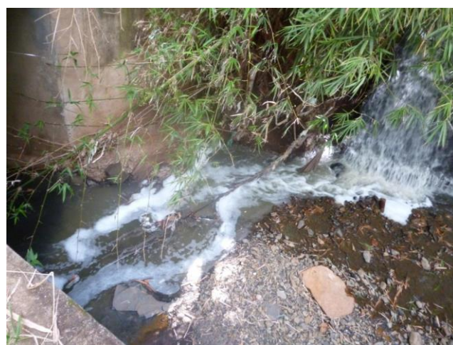
Foto 4.24 - Lançamento Efluente Tratado
