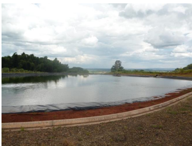
Foto 4.23 - Vista Geral da ETE
