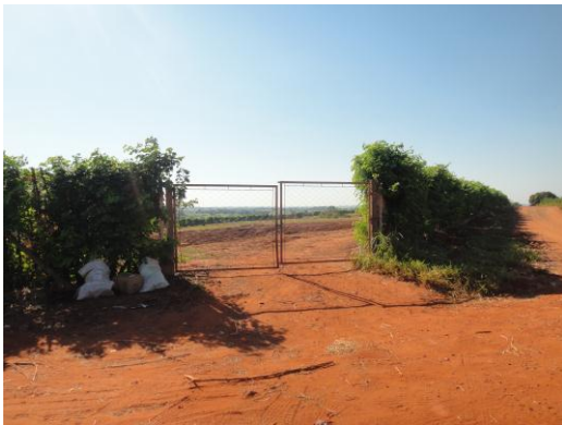
ENTRADA DO ATERRO EM VALAS.
