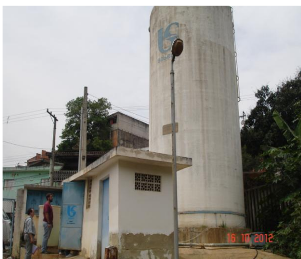
Reservatório R5 junto à EEAT.
