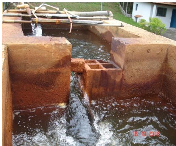
Canal de chegada da água bruta à ETA.
