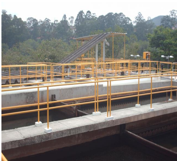
Vista superior da ETA Bacuri.
