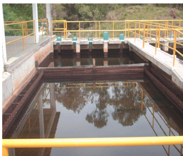
Vista longitudinal de um dos decantadores.
