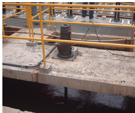
Vista de um dos floculadores, dotado de agitador mecânico.
