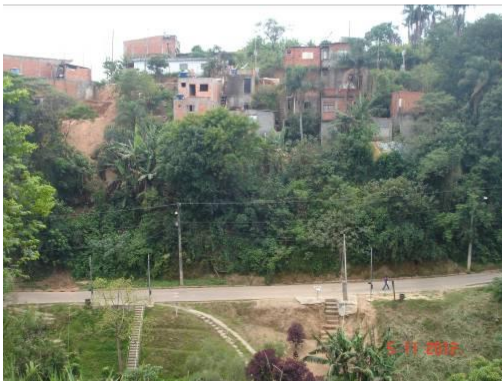
Vista geral da encosta (Rua dos Sabiás / Rua do Rouxinól).
