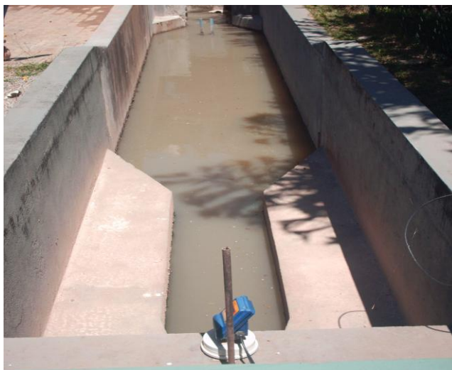
Canal de chegada de esgoto à ETE.
