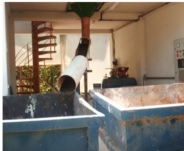
Lodo desaguado sendo armazenado.
