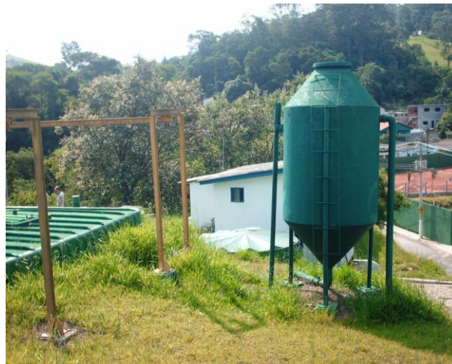
Vista parcial da ETE New Ville.
