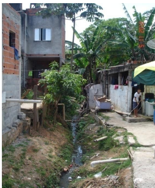
Figura 1-Ocupação de Encosta
