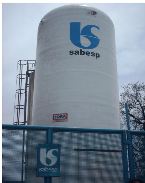
Vista do Reservatório R 7 – São Pedro.
