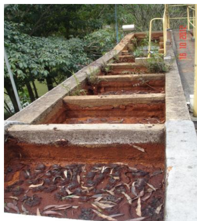
Vista superior da câmara de floculação.
