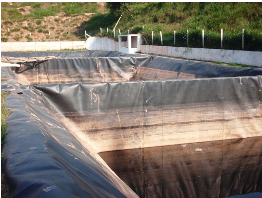
Lagoa Coletor de lixiviado aterro Tecipar
