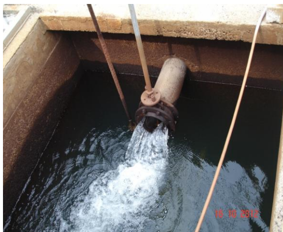
Vista superior de um dos filtros existente, detalhe para a queda da água do decantador.
