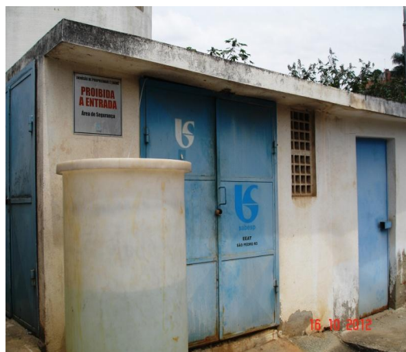
Instalação que abriga a EEAT São Pedro – R5.
