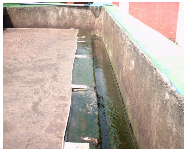
Decantador - canaleta de coleta do efluente.
