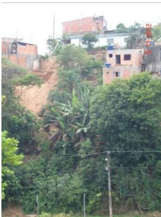
Vista geral da encosta (Rua dos Sabiás / Rua do Rouxinól).
