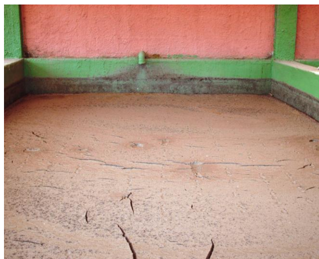
Lodo em processo de secagem.
