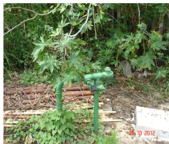
Detalhe do Poço desativado junto à EEAT São Pedro – R5.
