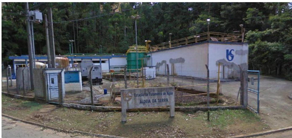
Vista geral da ETA Aldeia da Serra.
