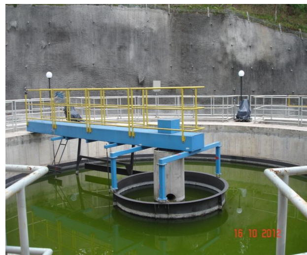
Vista interna do decantador.
