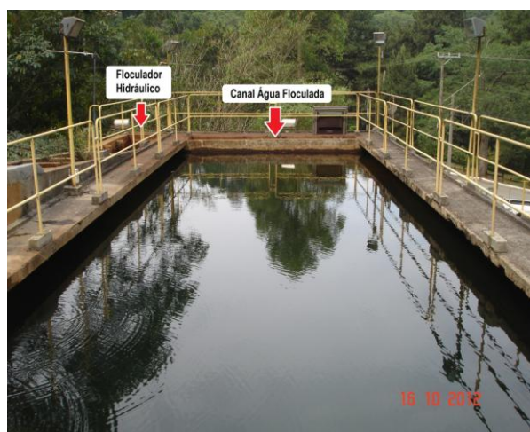
Vista do decantador com detalhe ao fundo para o floculador hidráulico e o canal que conduz a água floculada ao decantador..
