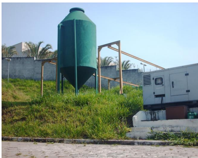
Vista parcial ETE New Ville.
