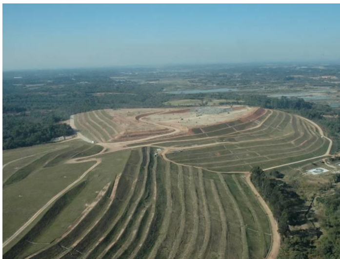
FIGURA 09: Aterro Sanitário Caximba - Curitiba
