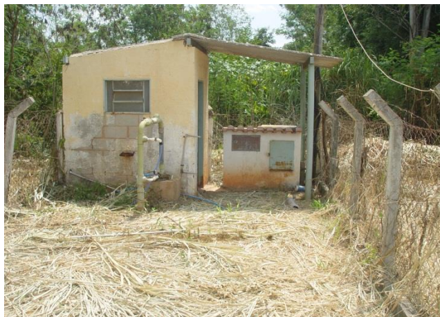
Foto 35 - Poço Vale Verde
