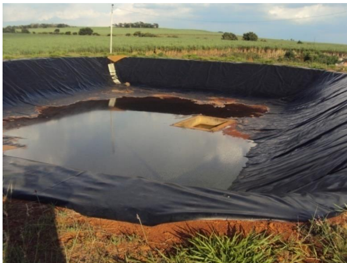
Foto 84 - Lagoa de lodo fora de operação na ETE
