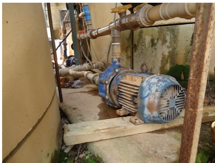
Foto 46 - ETA Rincão - estado de conservação dos equipamentos
