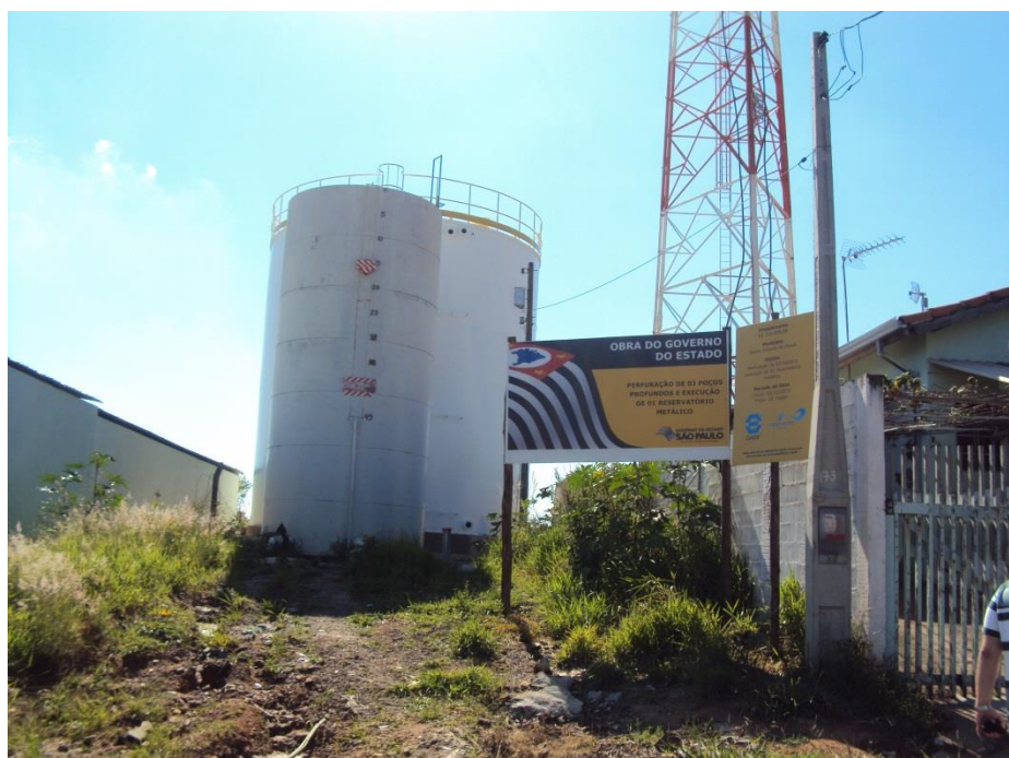
Foto 16 - Reservatórios de 100 e 500 m³ e Poço São Judas Tadeu
