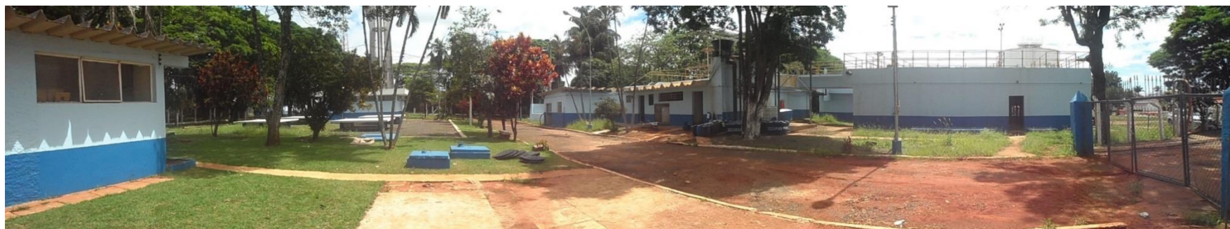
Foto 25 - Vista Geral da ETA Centro
