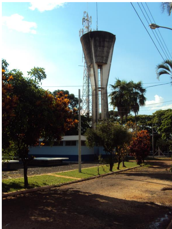
Foto 17 - Reservatório elevado desativado na ETA
