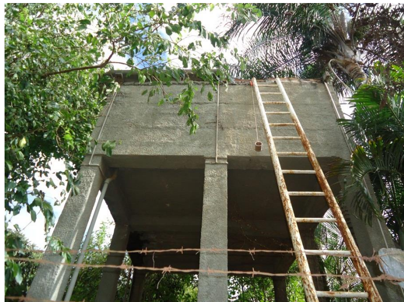
Foto 39 - Reservatório Vista Alegre
