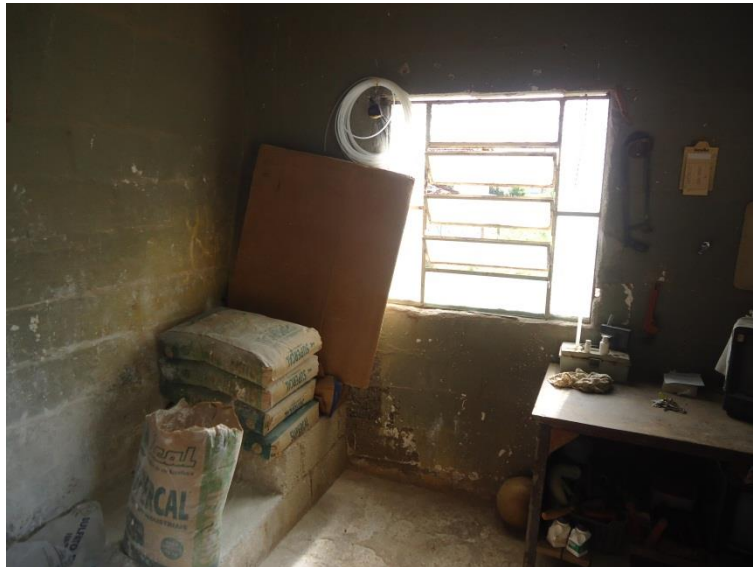
Foto 49 - ETA Rincão - depósito de produtos químicos
