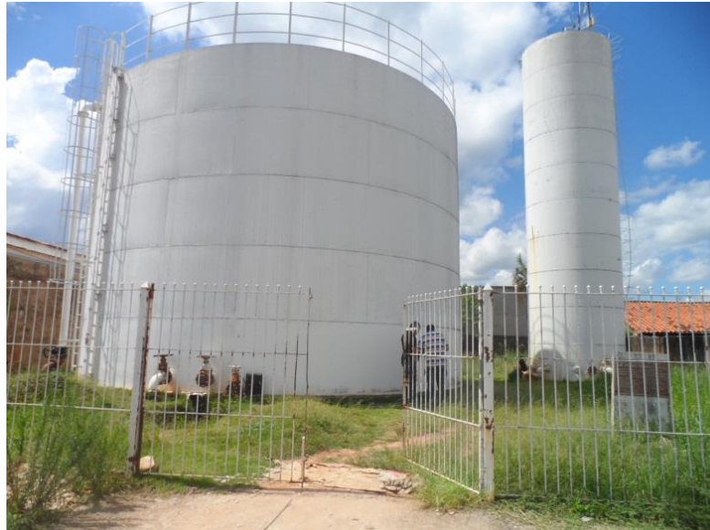
Foto 28 - Reservatório Pedra Branca II
