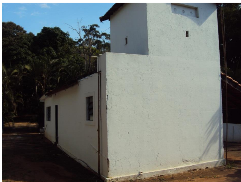
Foto 5 - Prédio da EEAB-1
