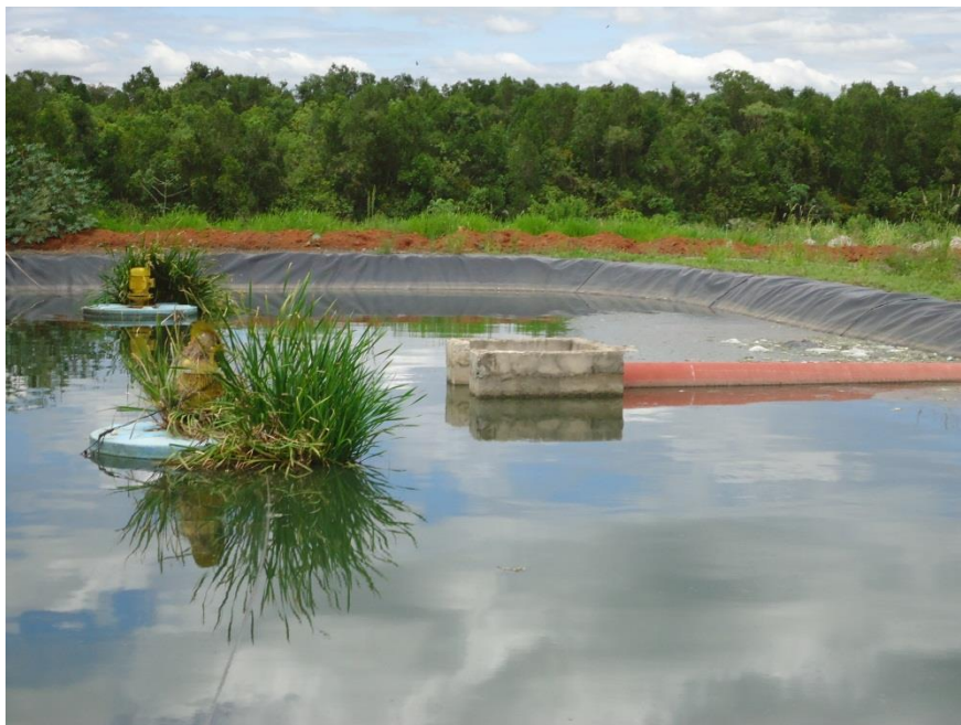
Foto 77 - Aeradores desligados e estado de conservação da lagoa, com vegetação e dispositivo de saída de efluentes
