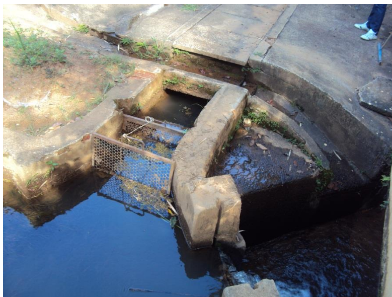
Foto 3 - Grades na tomada de água
