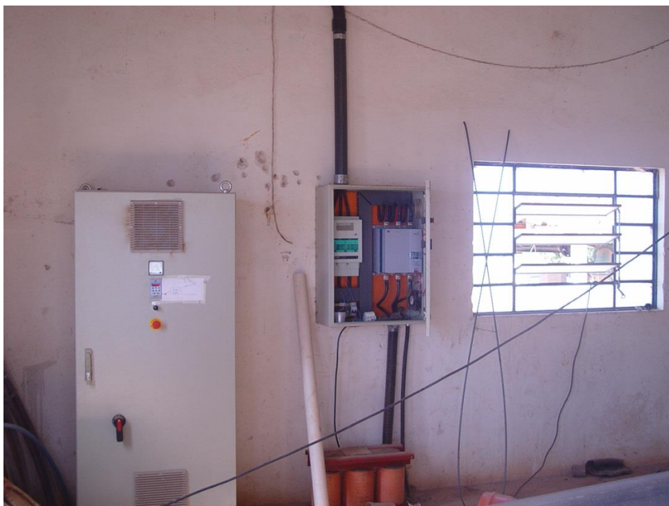
Foto 66 - Interior da EEE Camanducaia
