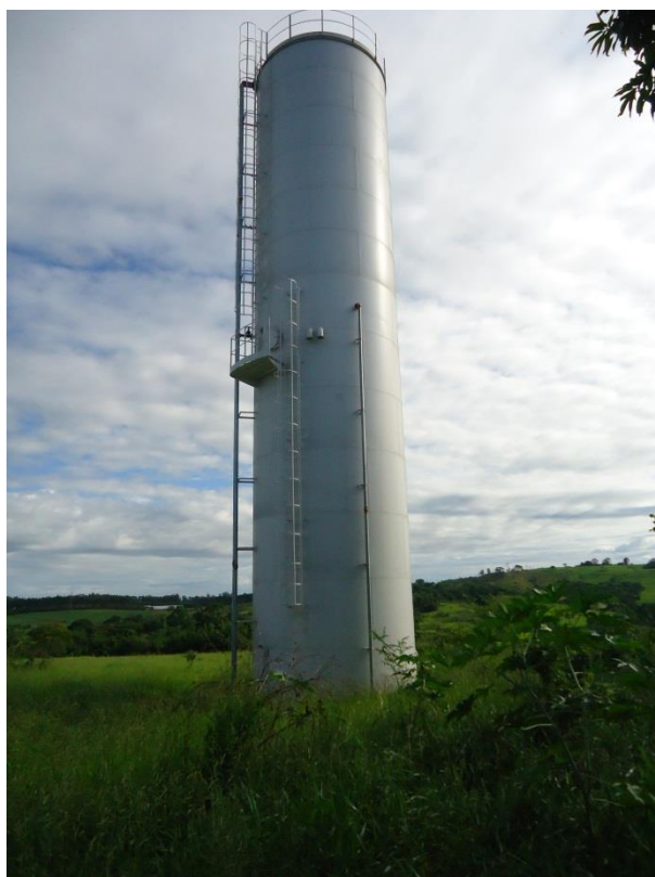
Foto 27 - Reservatório Elevado Pedra Branca
