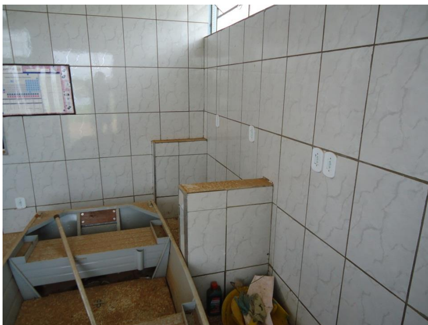
Foto 82 - Interior do laboratório, sem bancada e equipamentos
