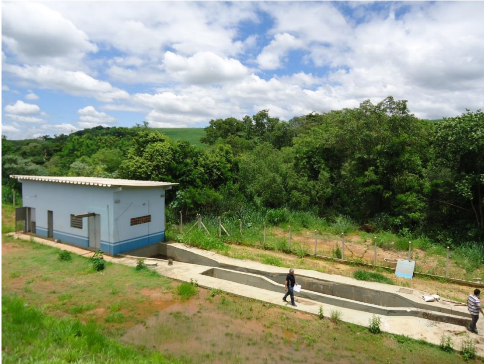
Foto 68 - Estação Elevatória de Esgotos Ressaca
