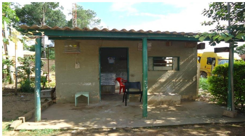
Foto 48 - ETA Rincão - depósito de produtos químicos
