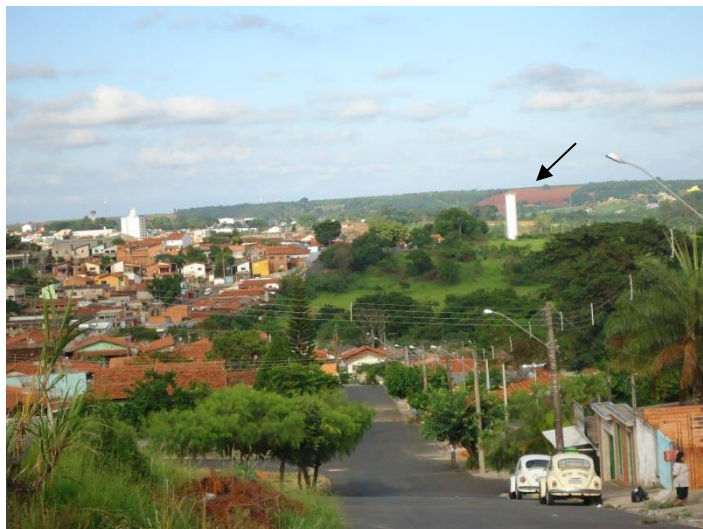
Foto 26 - Reservatório Elevado Pedra Branca
