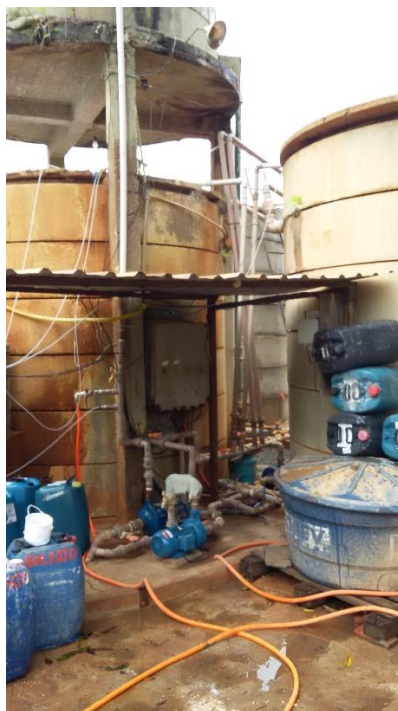
Foto 47 - ETA Rincão - estado de conservação das instalações
