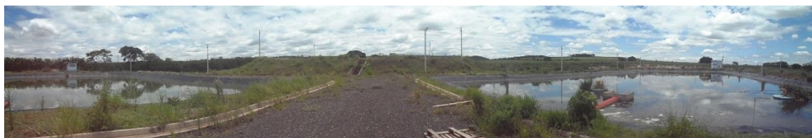
Figura 3 - Vista geral da Estação de Tratamento Existente
