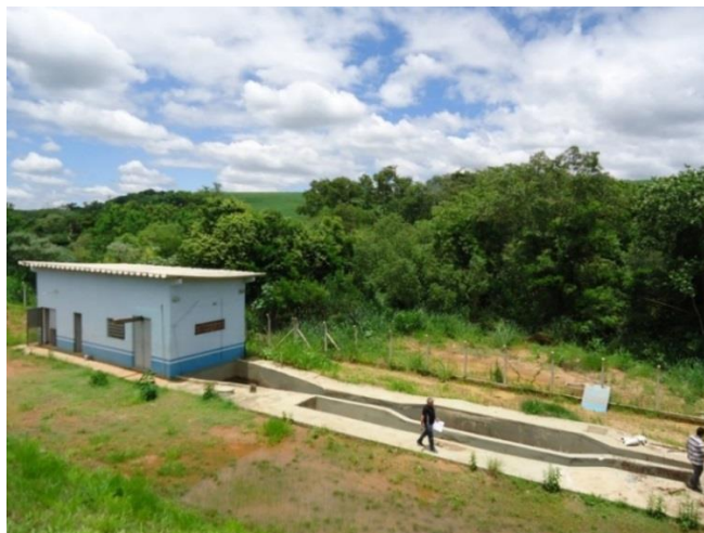
Figura 2 - Estação Elevatória Ressaca - Vista Geral
