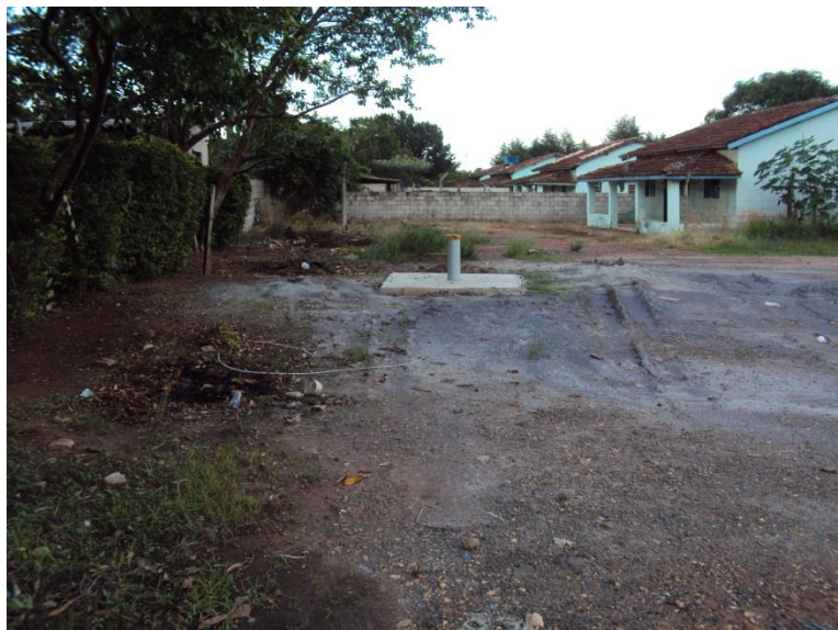
Foto 50 - Poço Rincão, localizado em terreno ao lado da ETA(Desativado).
