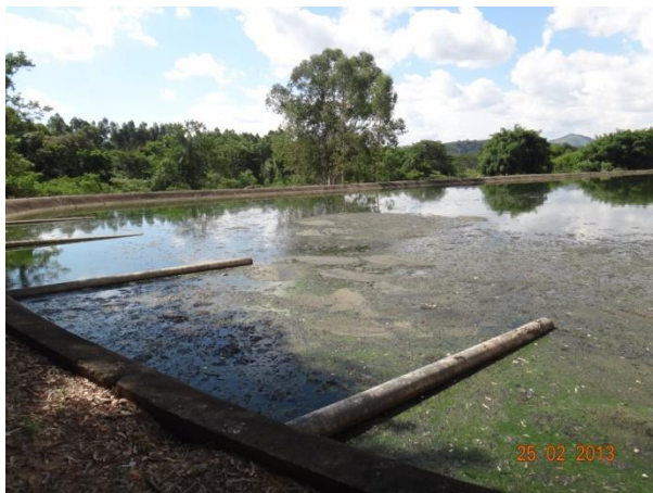
Foto 4.9 - Entrada do esgoto bruto - Lagoa Facultativa
