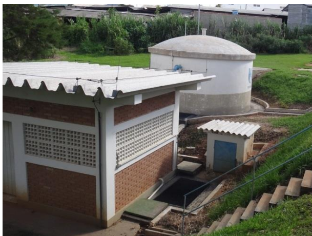
Foto 4.8 - EEAT1 e RA1
