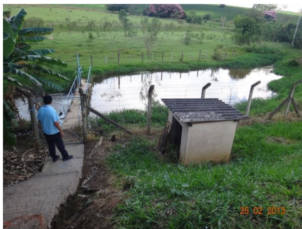
Foto 4.1- Barragem de nível - captação Ribeirão Jardim.
